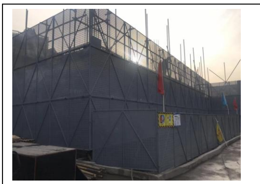
图 5. 配套楼施工现场
