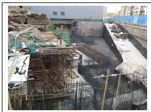
图 4. 地库及北侧配套楼施工现场
