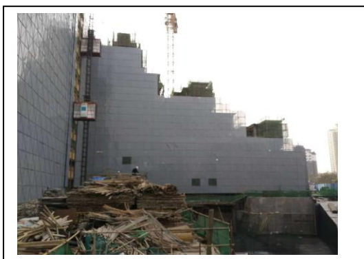
图 3. 住宅楼施工现场
