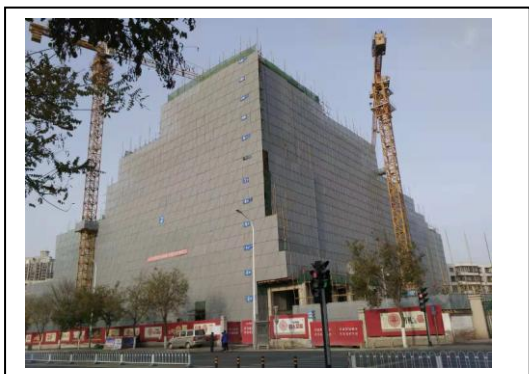
图 1. 住宅楼施工现场
