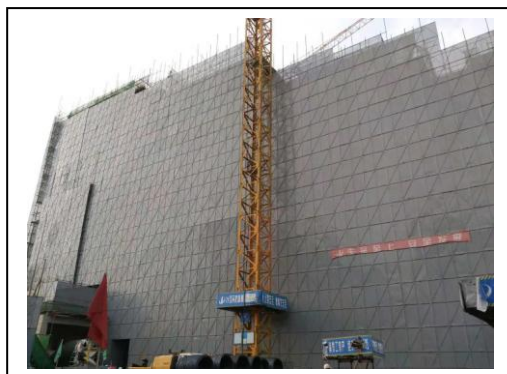
图 2. 住宅楼南侧施工现场
