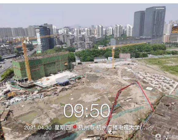
4、项目地块 6#楼施工至首道支撑完成，9/10#楼二层土开挖
