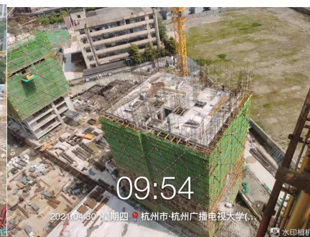
6、项目地块 3#楼施工至 9 层结构顶板完成
