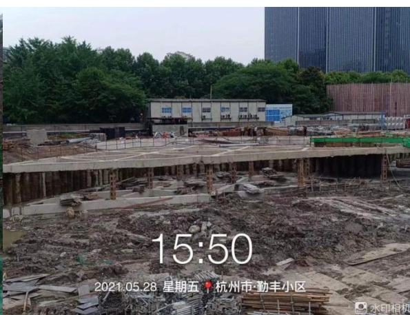
4、项目地块 9#、10#楼施工至二道角撑具备浇筑条件
