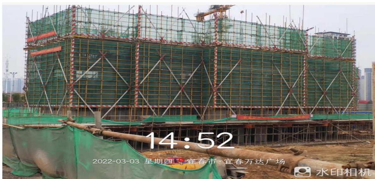
9#主体施工至三层
