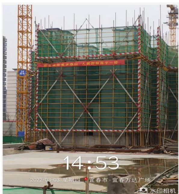
10#主体施工至三层
