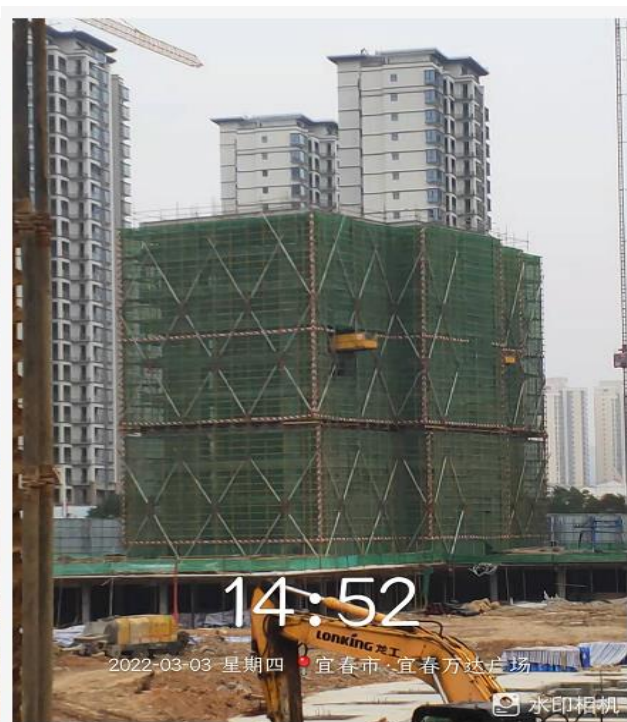
3#主体施工至八层
