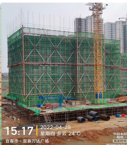
9#七层梁板铺设模板中
