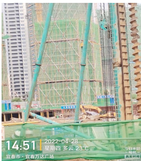
5#十三层墙柱钢筋绑扎中
