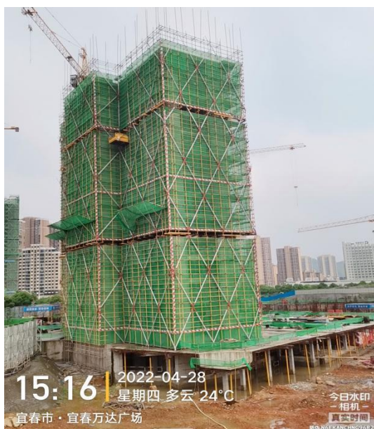
2#十四层梁板模板铺设
