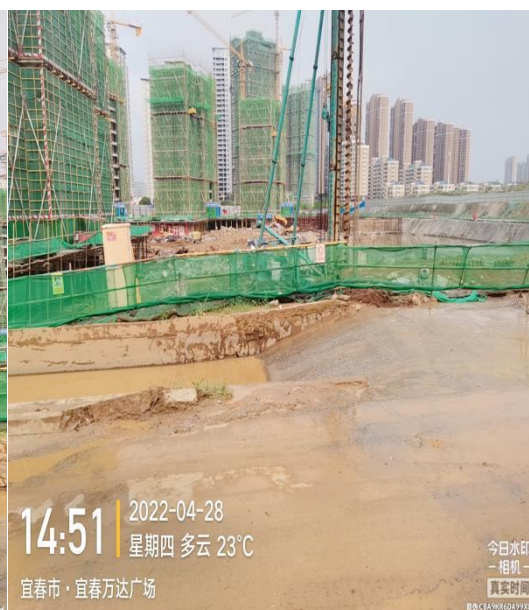
其它楼栋（除 1#、4#、11#）处于 地下室施工阶段
