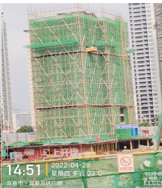
3#十四层梁板钢筋绑扎中
