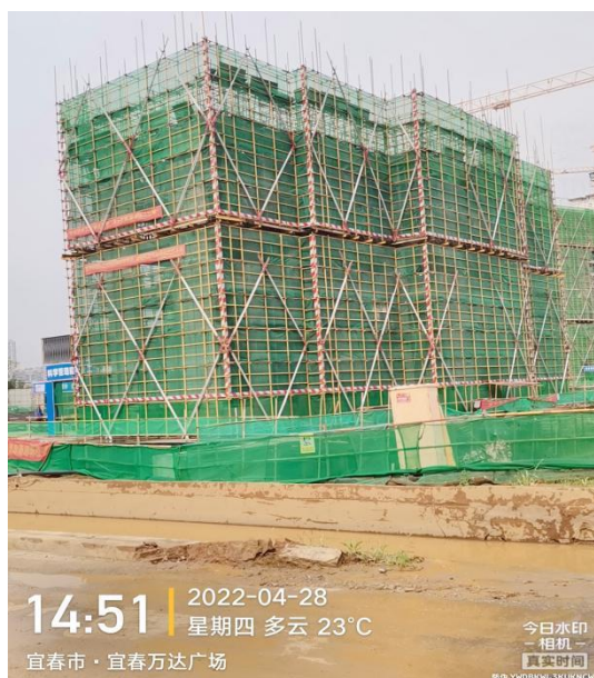
10#七层梁板铺设模板中
