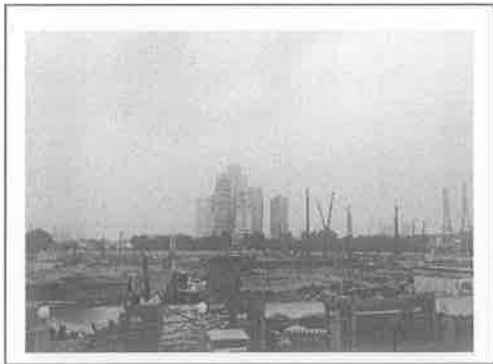
3. 项目施工现场
