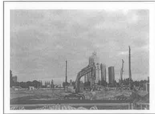
4.项目施工现场
