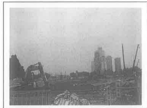
6.项目施工现场
