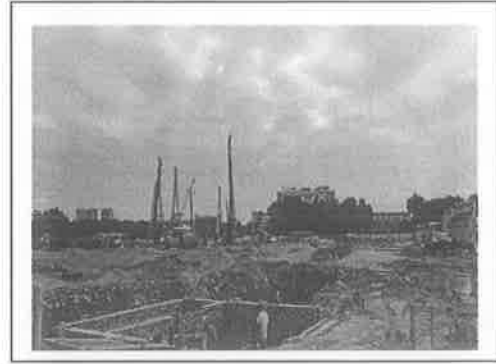
2.项目施工现场
