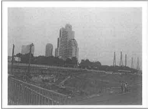
1.项目施工现场
