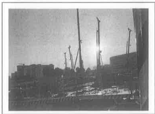
5.项目施工现场
