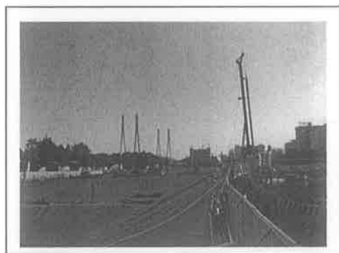
4.项目施工现场
