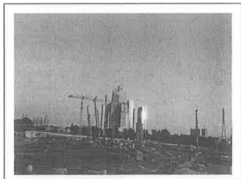
2.项目施工现场
