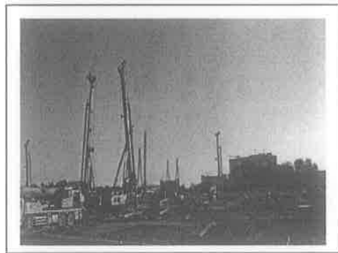
6.项目施工现场
