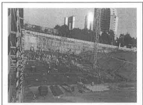
1.项目施工现场
