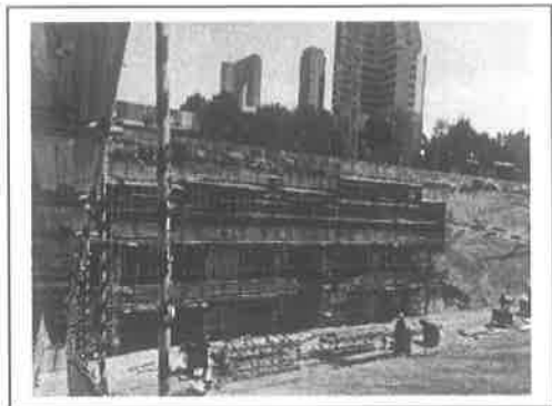
1.项目施工现场
