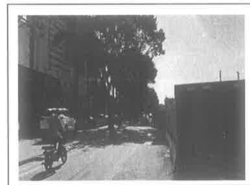
6.塌陷处安全围挡设施
