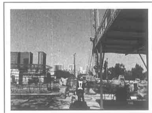
4.项目施工现场
