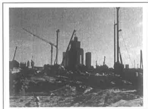
3.项目施工现场
