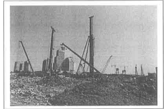
2. 项目一期旋挖桩施工
