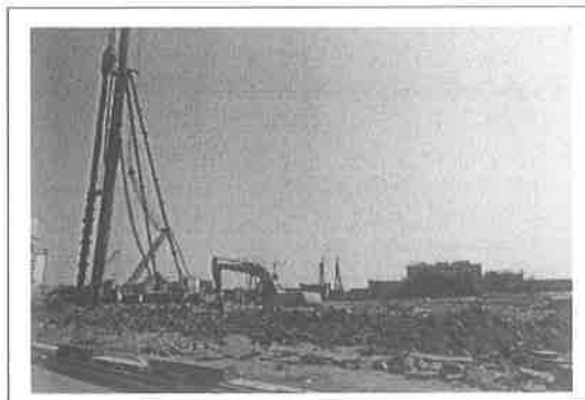
3. 项目一期旋挖桩施工
