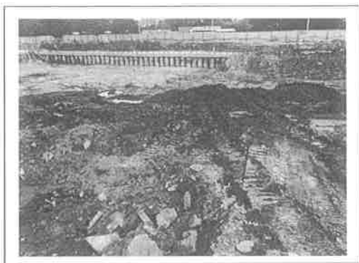
3. 项目一期施工现场
