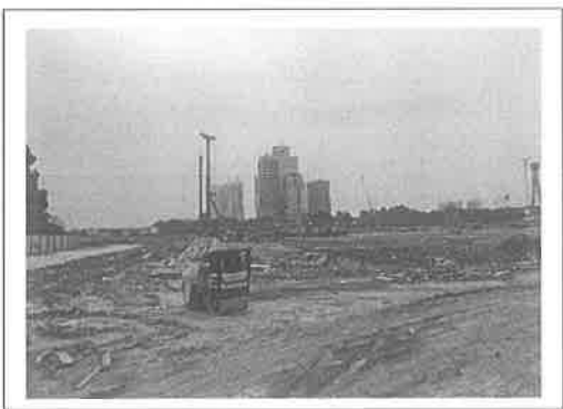
5. 项目办公板房修建
