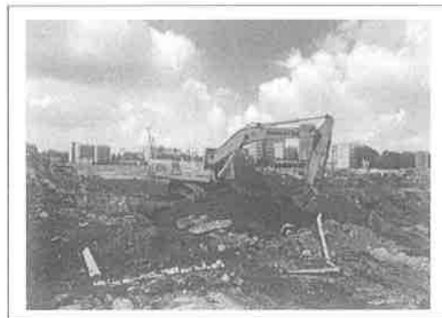
2. 项目施工现场一览
