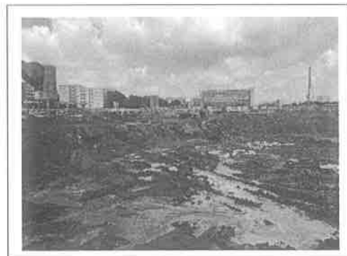
4. 项目一期施工现场
