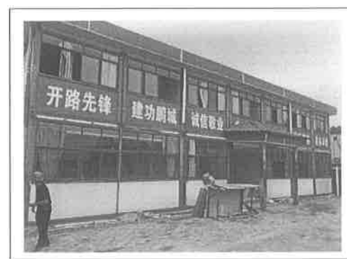
6. 项目办公板房修建
