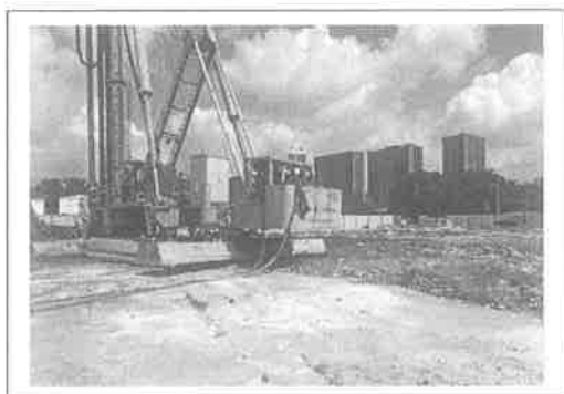
1. 项目施工现场一览
