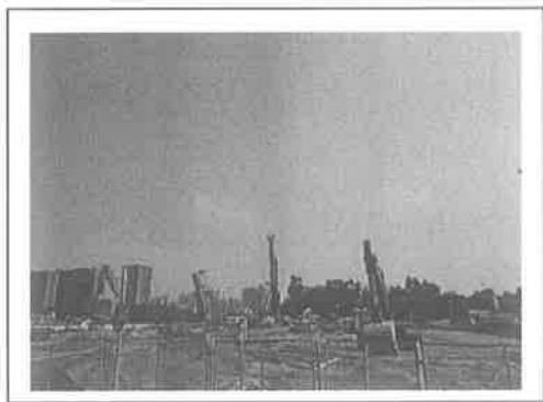
3. 项目施工现场
