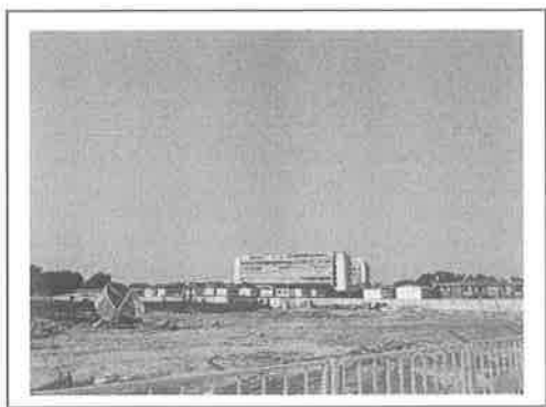
1.项目施工现场
