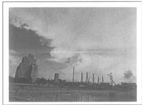
6.项目施工现场
