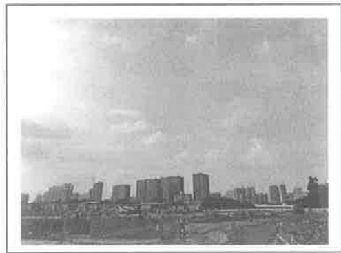
4.项目施工现场
