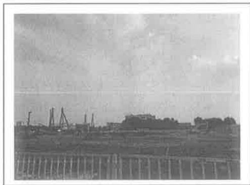
5. 项目施工现场
