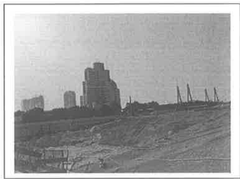
2.项目施工现场
