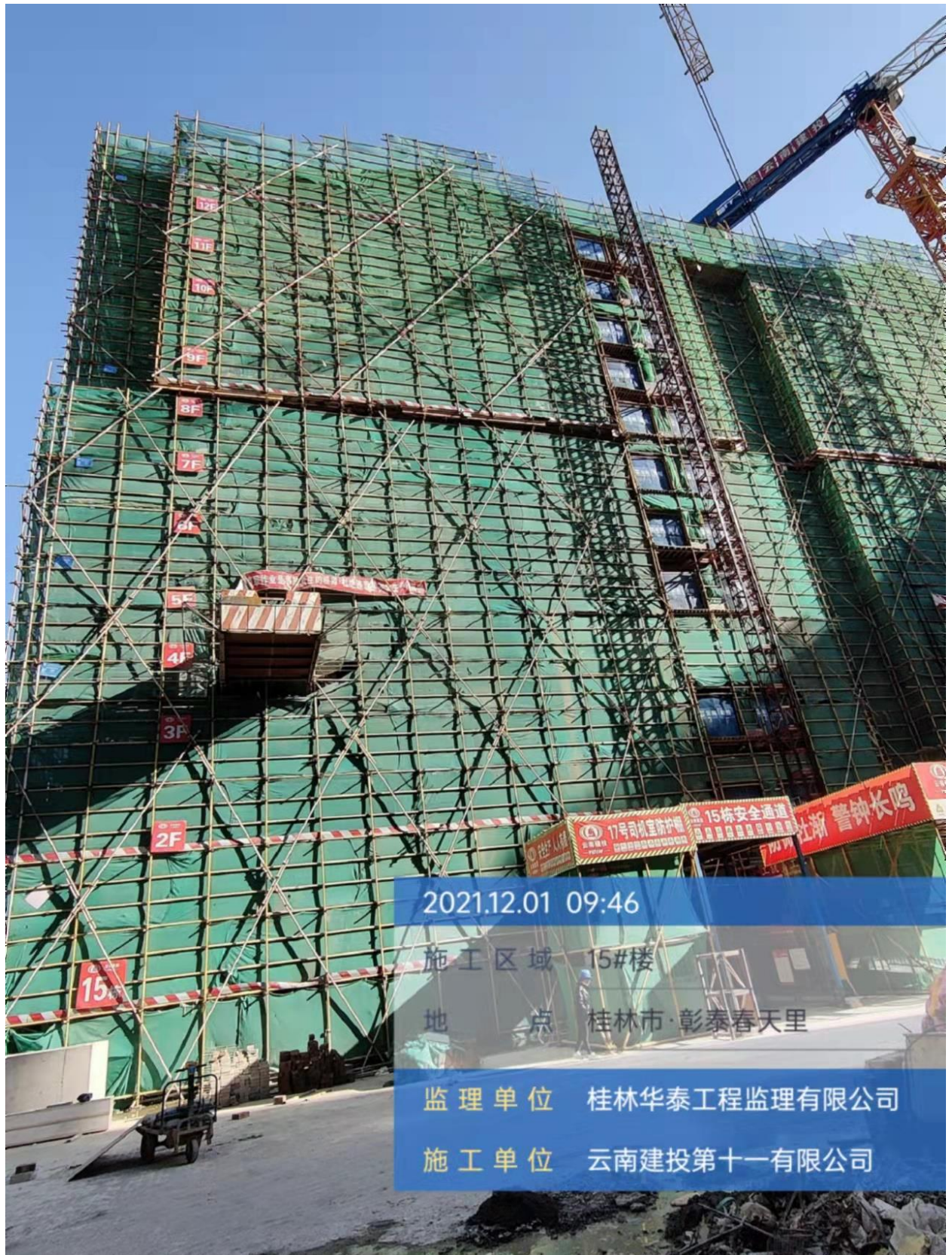
15#楼铝合金窗安装完成，内墙抹灰1-6层完成
