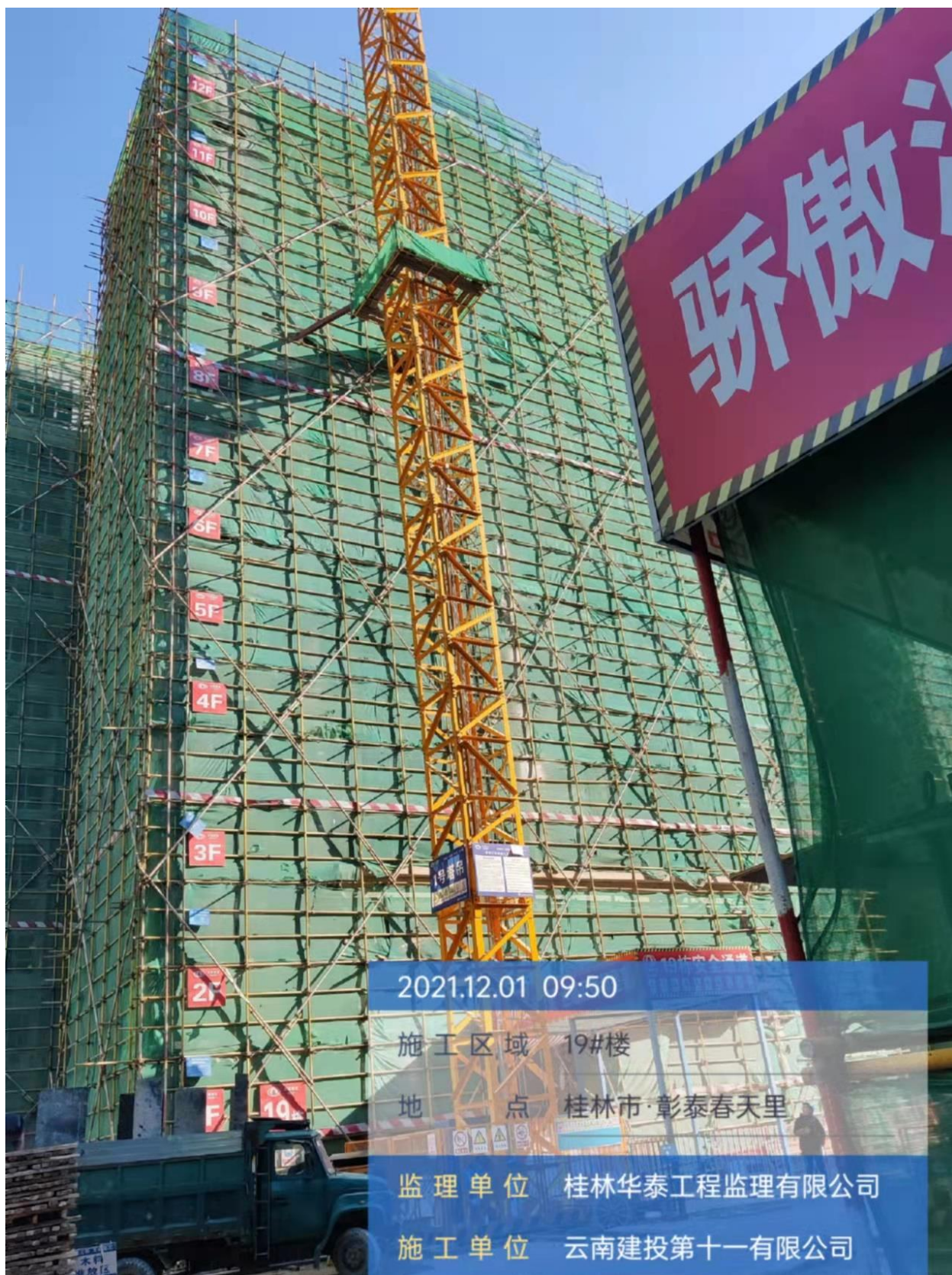
19#楼内墙抹灰 1-10 层完成，铝合金窗完成，外墙抹灰 1-8 层完成
