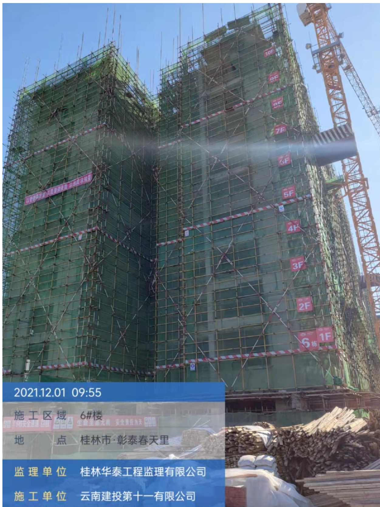
6#一单元 11 层模板安装，二单元 10 层内架搭设完成
