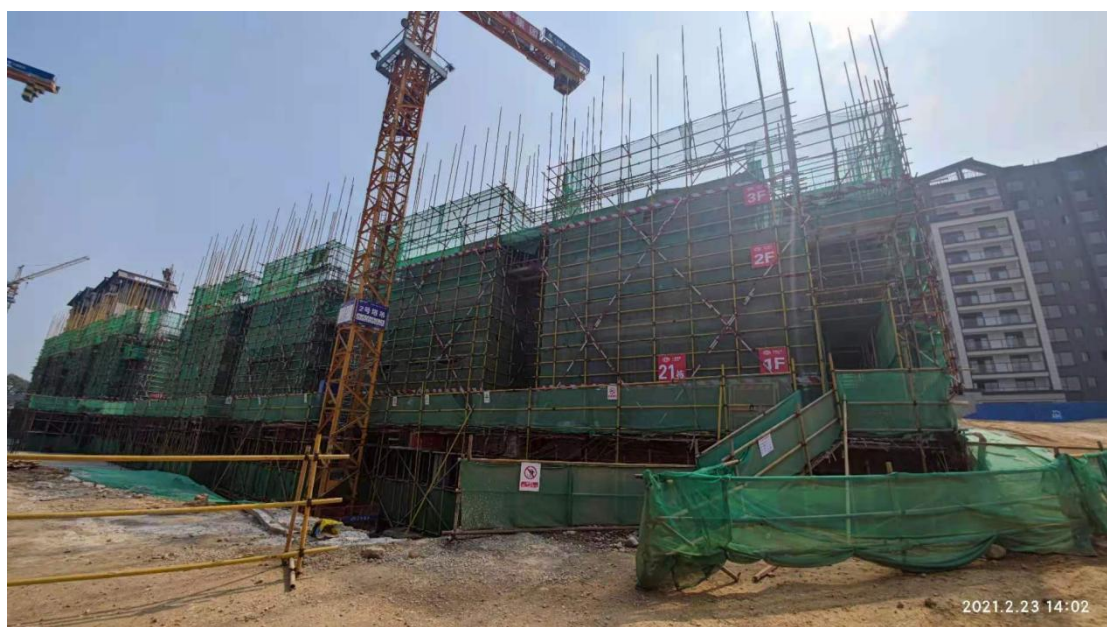
21#楼四层梁板砼浇筑完成
