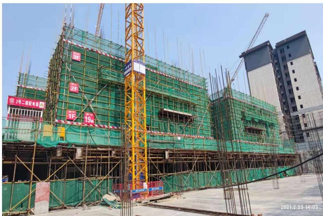
19#楼四层梁板砼浇筑完成
