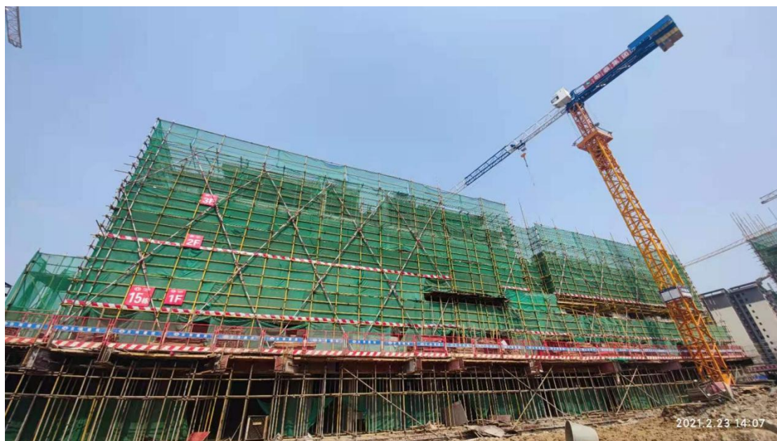
15#楼东单元五层梁板砼浇筑完成、西单元四层梁板砼浇筑完成
