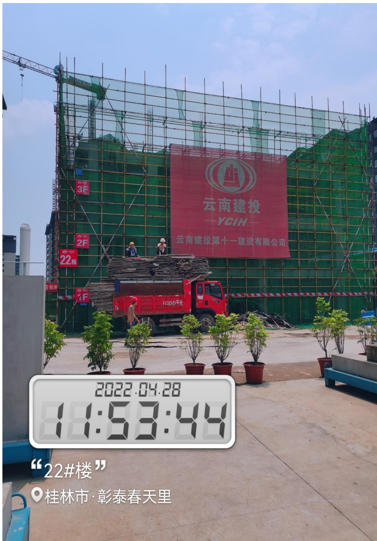
22#楼屋面梁板砼浇筑完成，1层拆模完成
