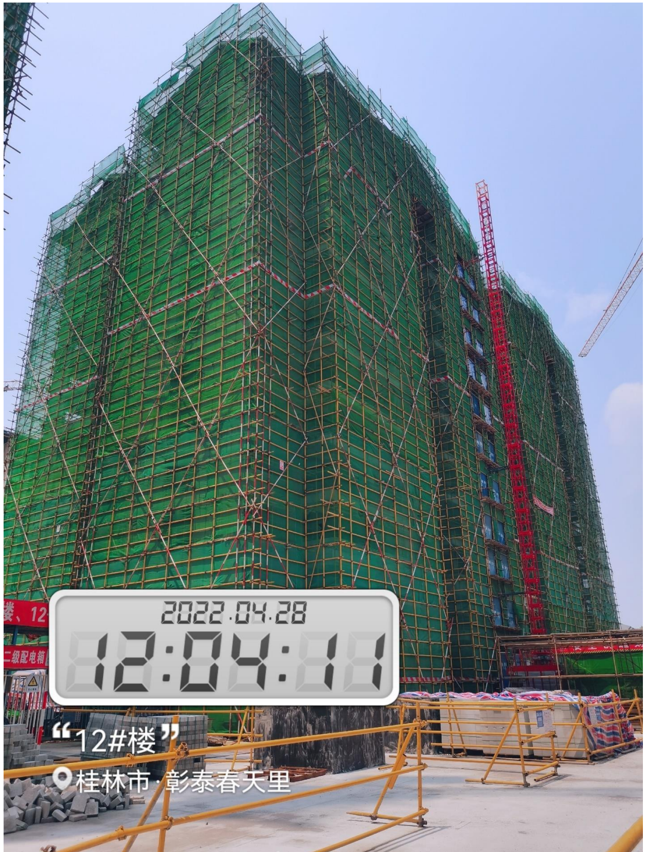
12#楼已主体结构封顶, 2 层砌体完成 50%
