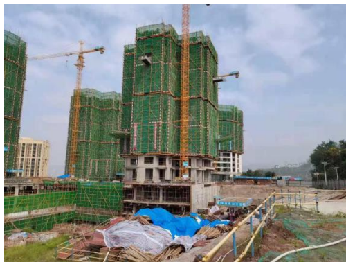
1 号楼施工现场
