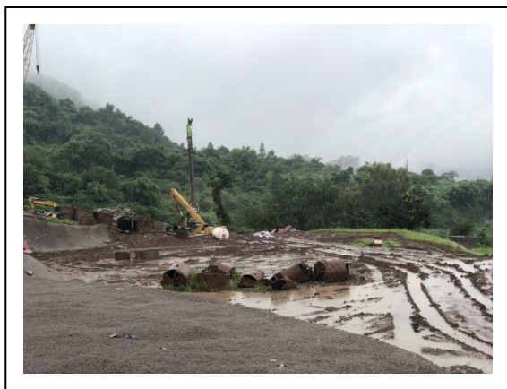
7-10 号楼施工现场
