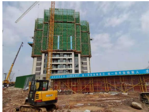
2 号楼施工现场
