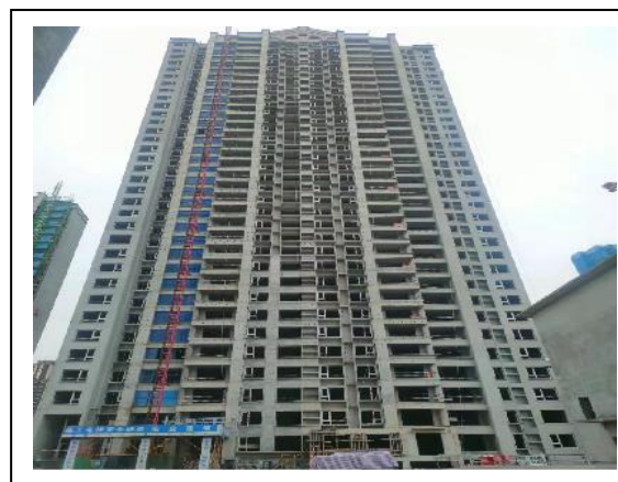
7、一期 4#号楼（二次结构施工）
