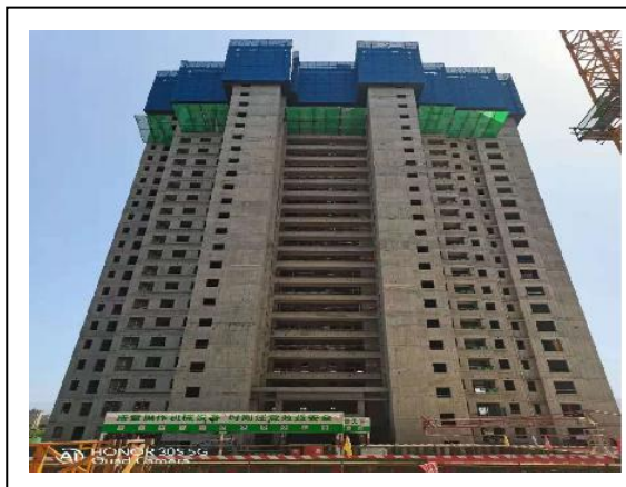
3、二期 5#号楼（主体施工）
