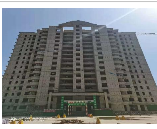
4、二期 7#号楼（二次结构施工）
