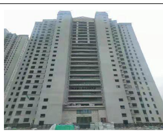
6、一期 3#号楼（二次结构施工）
