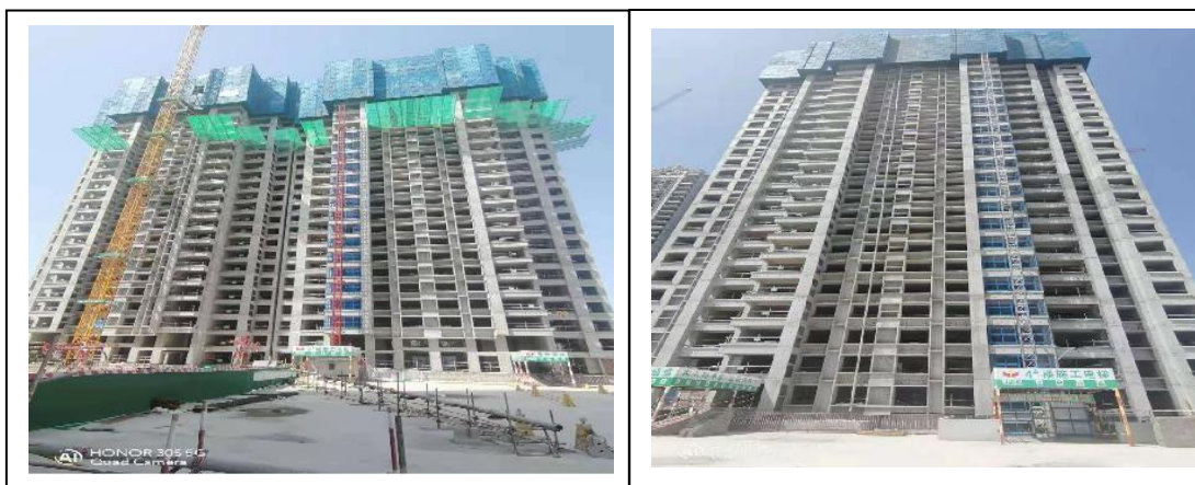
1、二期 3#号楼（主体施工）
