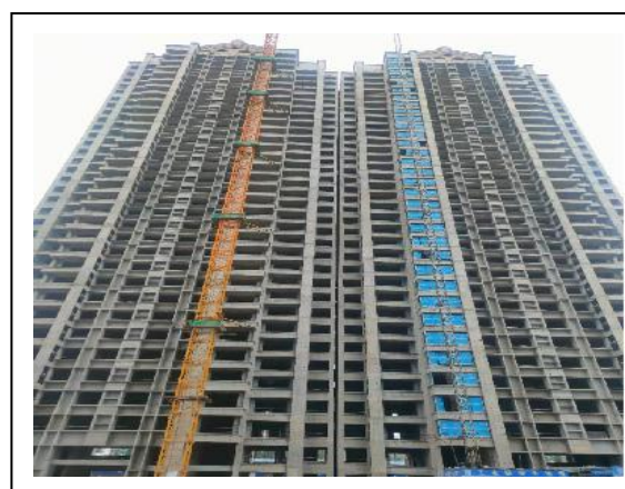
5、一期 1#号楼（二次结构施工）
