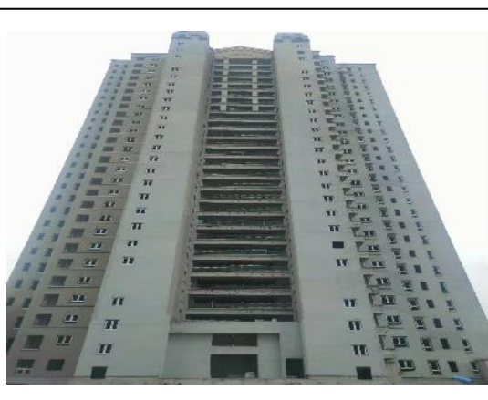
8、一期 7#号楼（二次结构施工）
