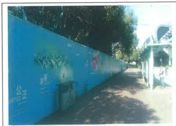
图 1. 施工场地围挡
