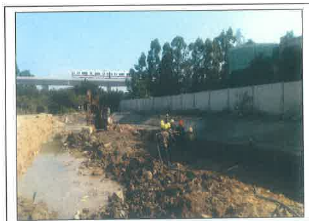
图 2. 施工现场基坑开挖
