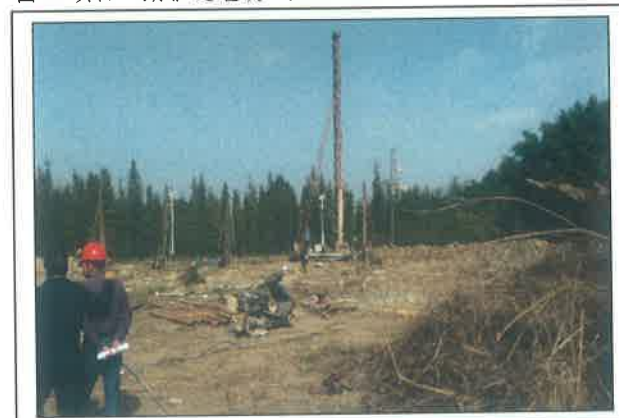
图 5. 项目一期钻孔打桩
