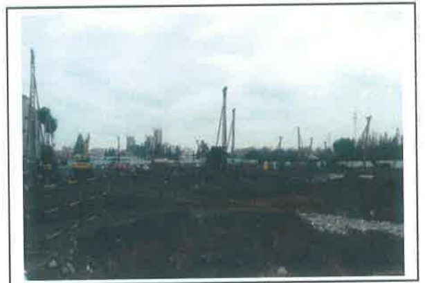
图 6. 一期大面积钻孔打桩
