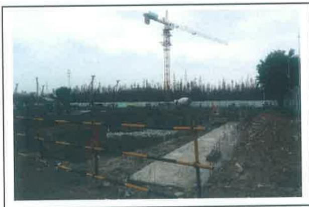
图 5. 基坑内清理施工
