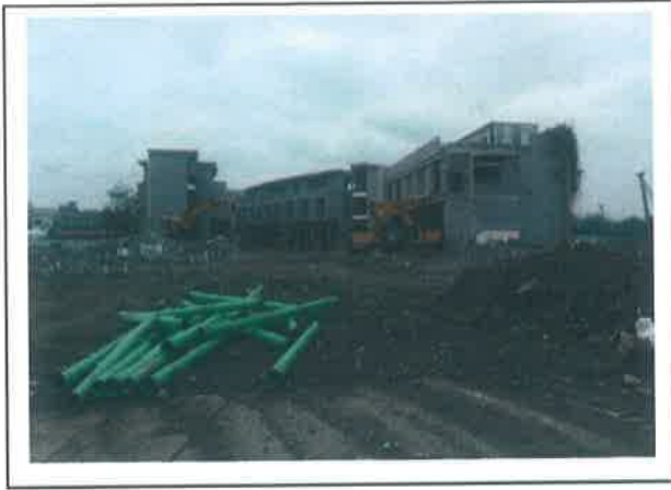
图 1. 一期原有建筑正在拆除废料已清理
