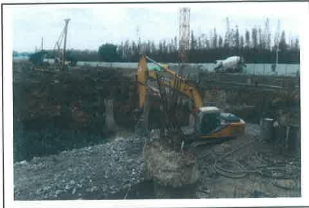
图 3. 基坑内填充渣土
