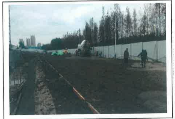
图 4. 施工人员正在硬化地面
