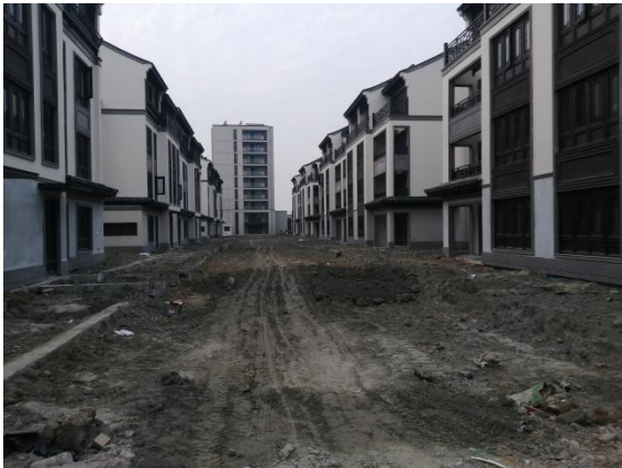
3、二期叠墅区土方回填完成
