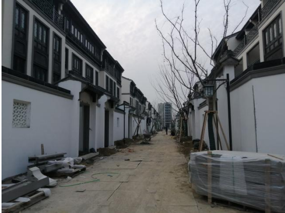
1、一期巷道围墙
