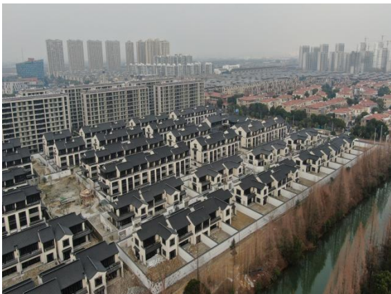
5、一期整体现状
