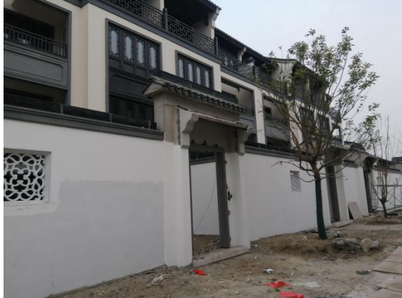
2、一期巷道围墙腻子工程施工中
