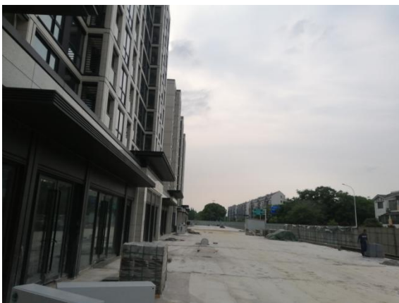
9、二三期室外场地硬化
