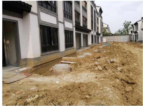
8、二三期叠墅区域室外管网施工
