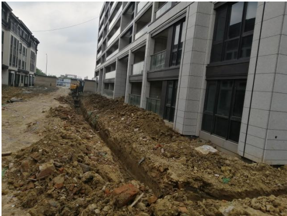
7、二三期小高层区域室外管网施工
