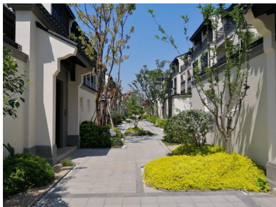
3、一期巷道现状
