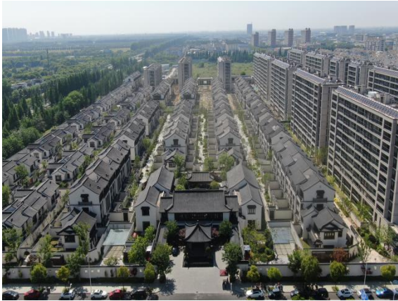
5、一二三期合院叠墅整体现状
