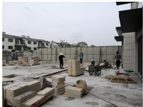
10、二三期室外道路石材铺装
