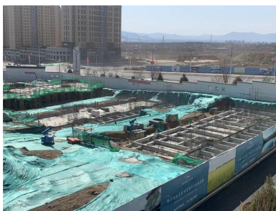
6. 1-7#、1-8#楼基础筏板浇筑完成
