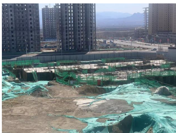
5. 1-2#、1-3#地下室顶板浇筑完成
