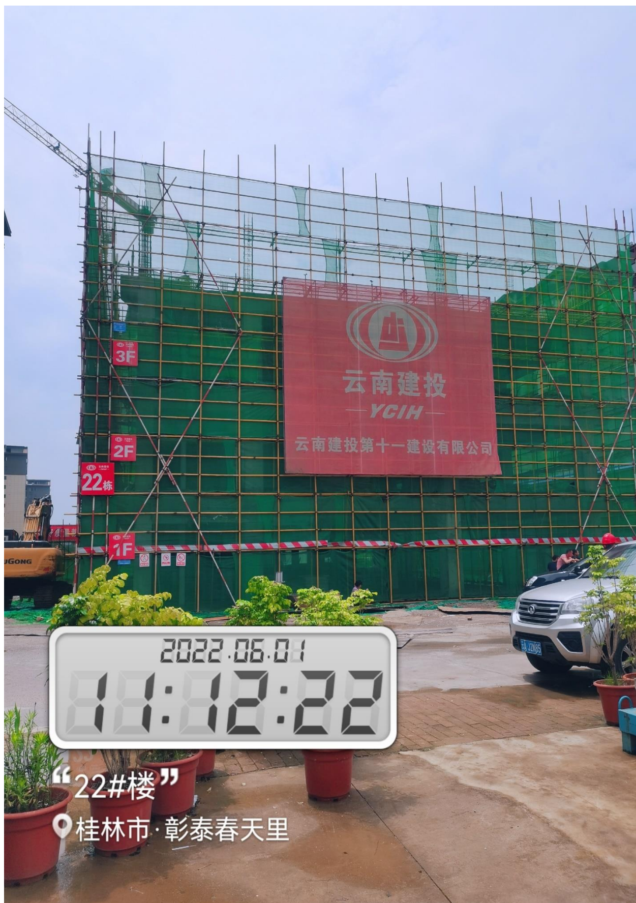
22#楼屋面梁板砼浇筑完成，2-3 层拆模完成
