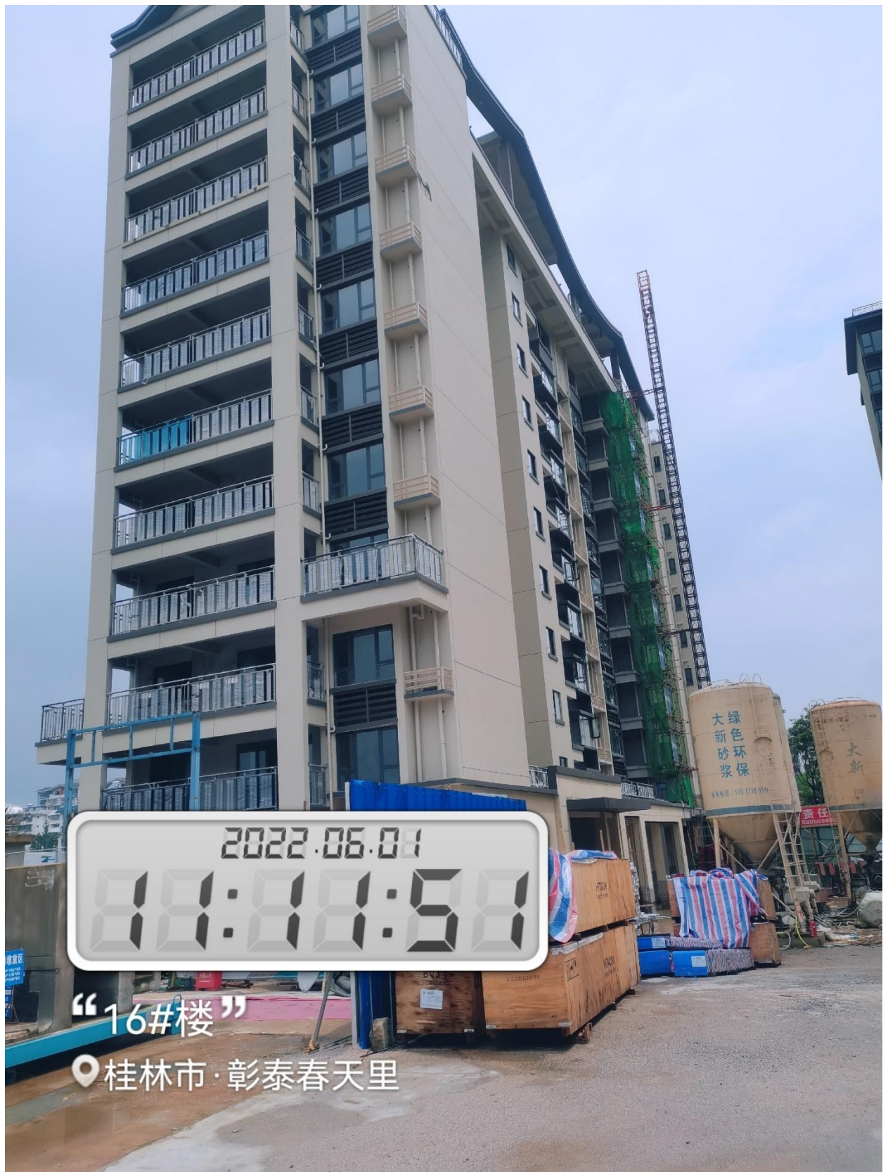
16#楼外墙涂料施工完成，外架拆除完成，地面找平完成，屋面工程完成，楼梯间找平完成，消防立管消防箱安装完成
