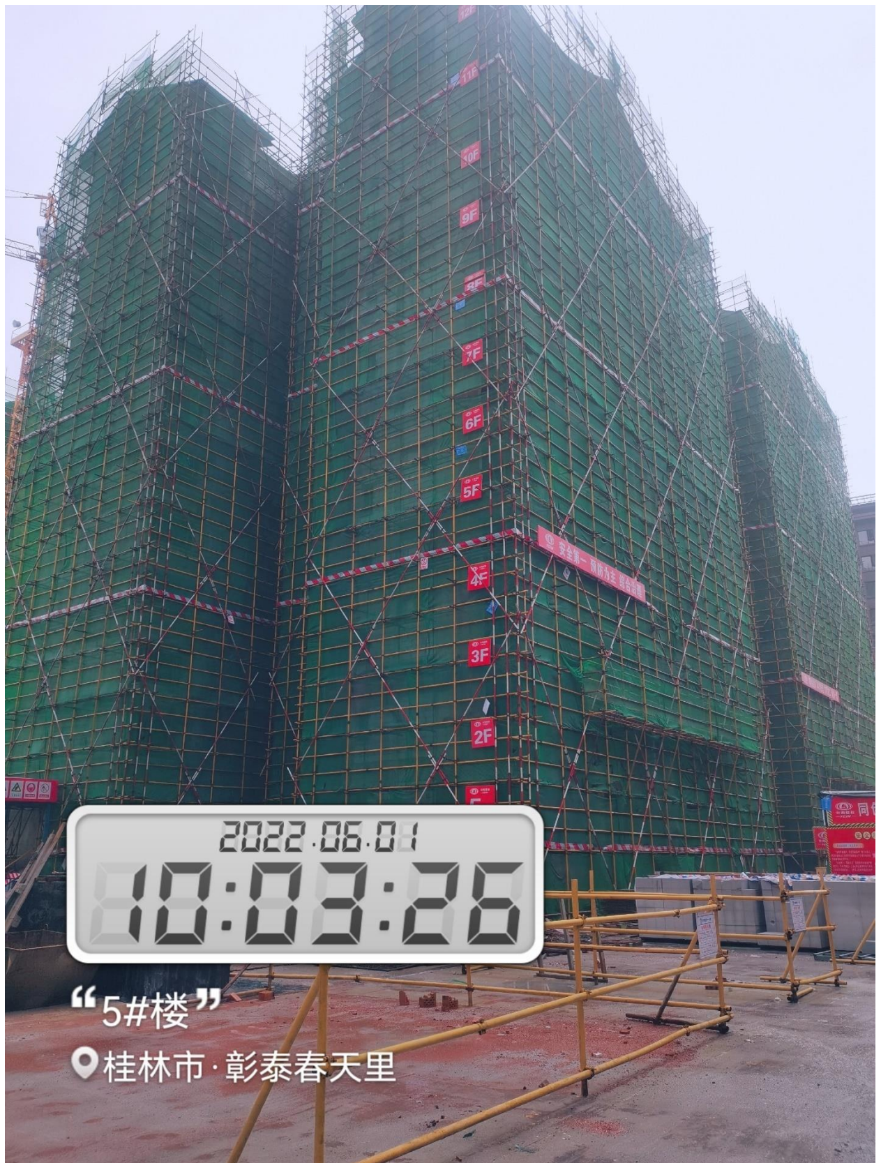
5#楼已结构封顶，3-11 层砌体完成
