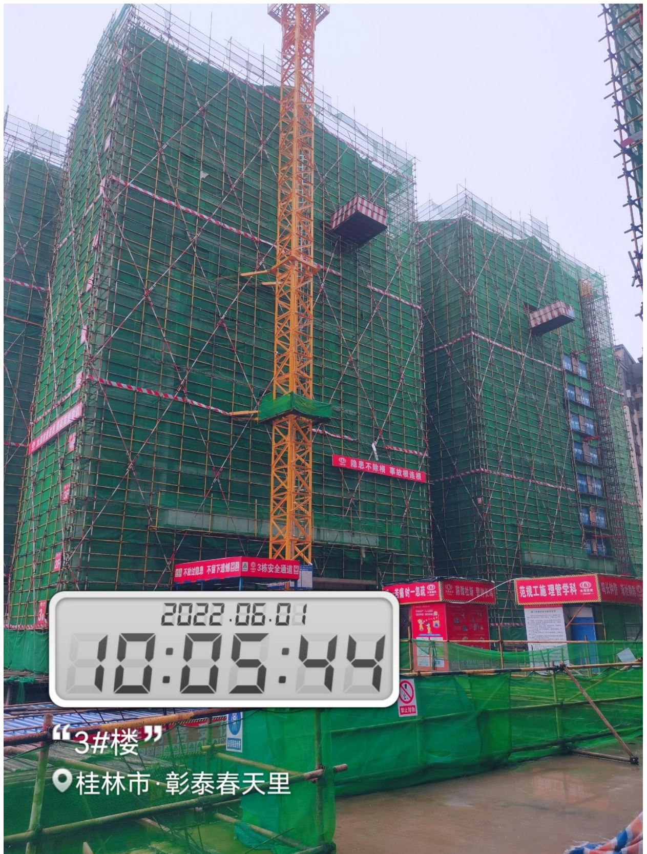
3#楼一单元斜屋面梁板支模完成，二单元斜屋面梁板钢筋完成 85%，7 层砌体完成 20%
