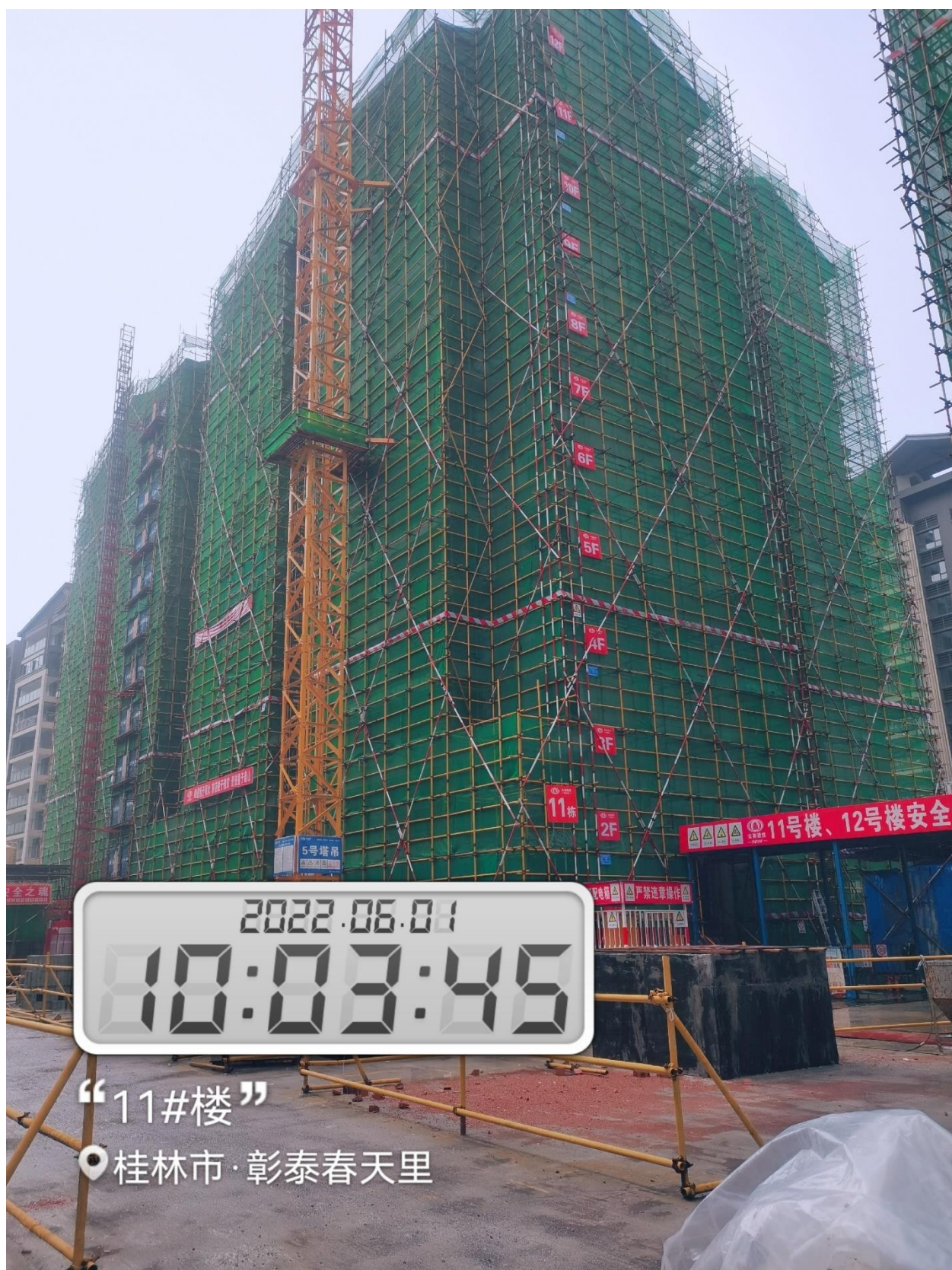
11#楼已主体结构封顶，2-12 层砌体完成，斜屋面涂料防水完成
