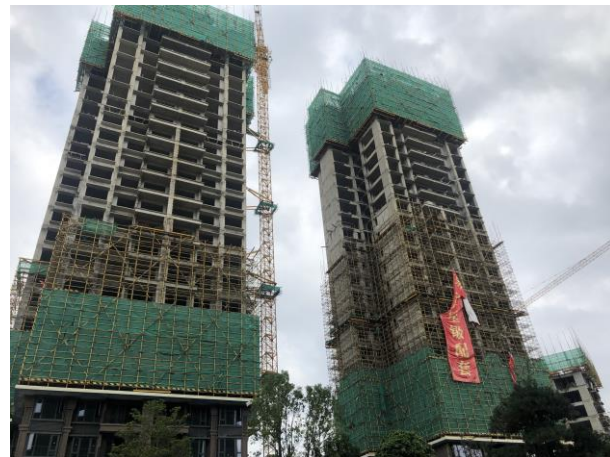
2.项目施工现场
