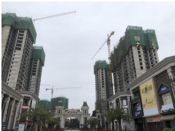
1.项目施工现场
