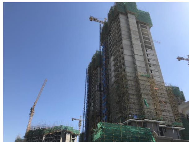
4.项目施工现场
