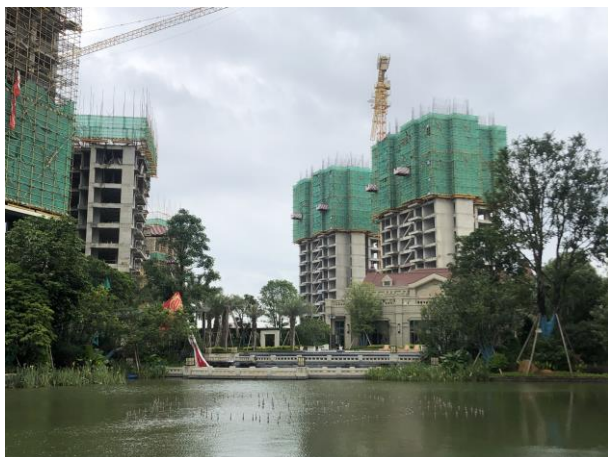
3.项目施工现场
