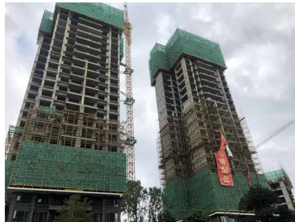
2.项目施工现场
