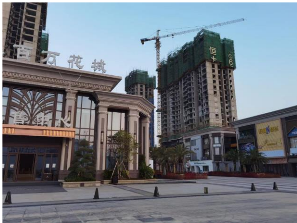
1.项目施工现场
