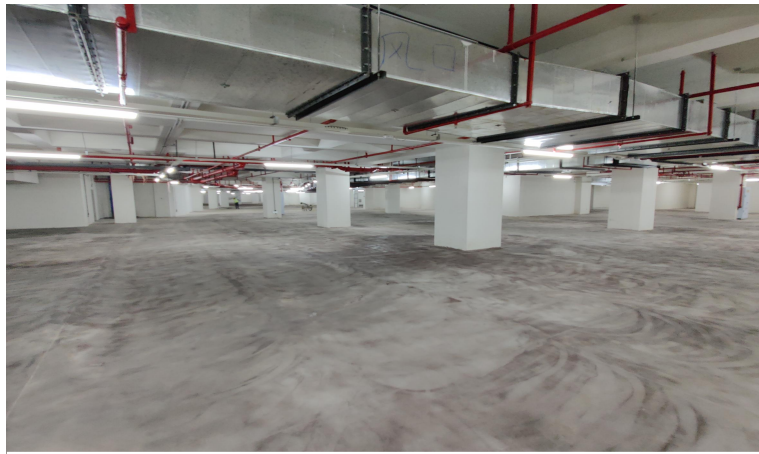
地下车库施工 02
