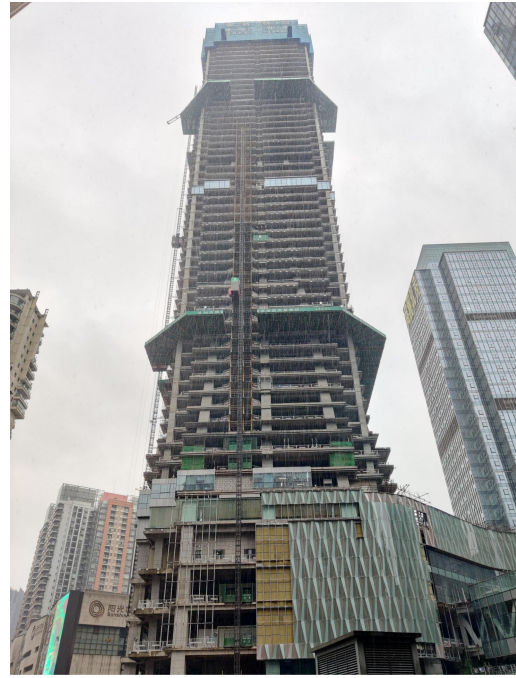
T1 塔楼南立面 57 层
