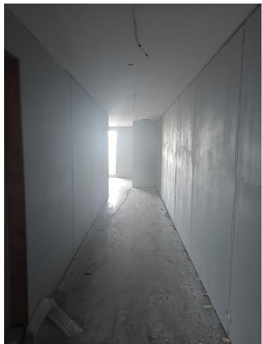
T1 塔楼 31 层样板间 03
