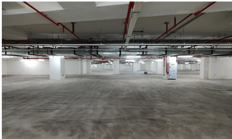
地下车库施工 05
