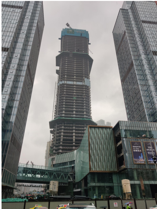
T1 塔楼东立面 57 层
