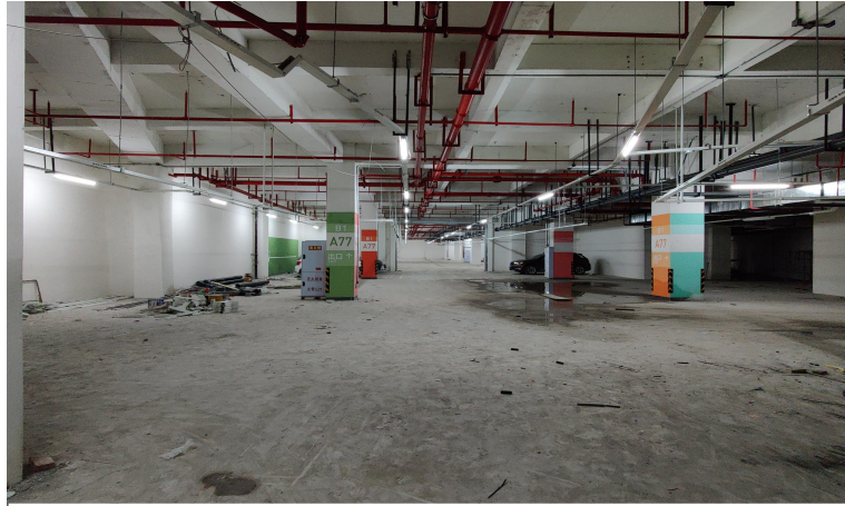
地下车库施工 01
