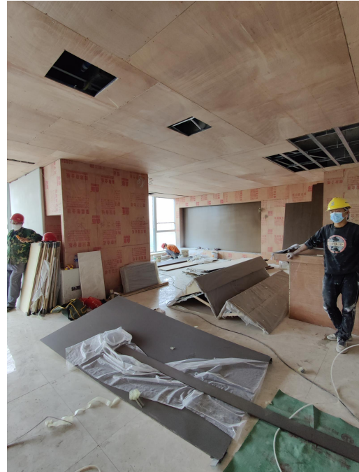
T1 塔楼 31 层样板间 01
