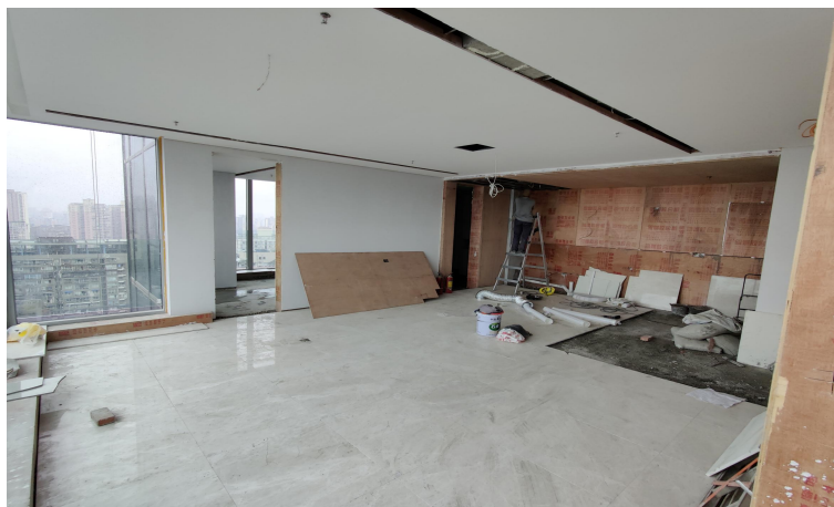
T1 塔楼 31 层样板间 02
