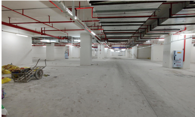
地下车库施工 04
