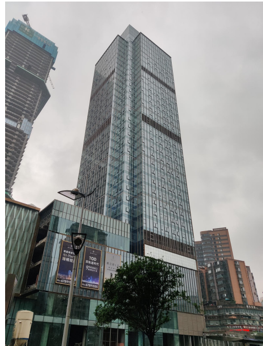
T2 塔楼东南面
