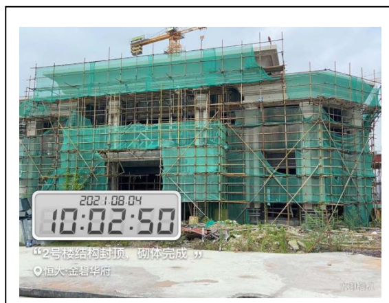
2#楼结构封顶、砌体完成
