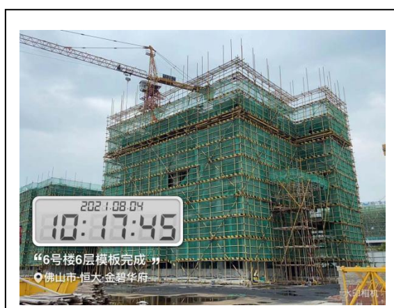
6#楼 6 层模板完成
