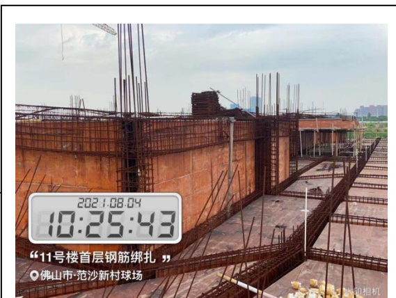
11#楼首层钢筋绑扎
