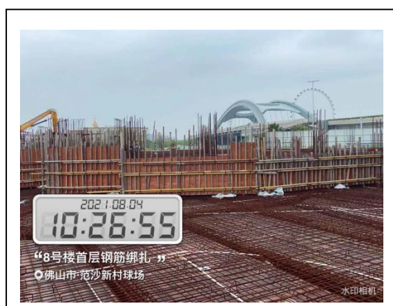
8#楼地下室顶板钢筋完成
