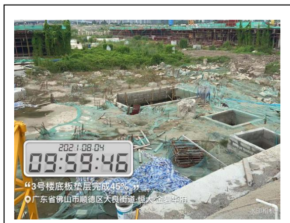
3#楼地板垫层完成 45%
