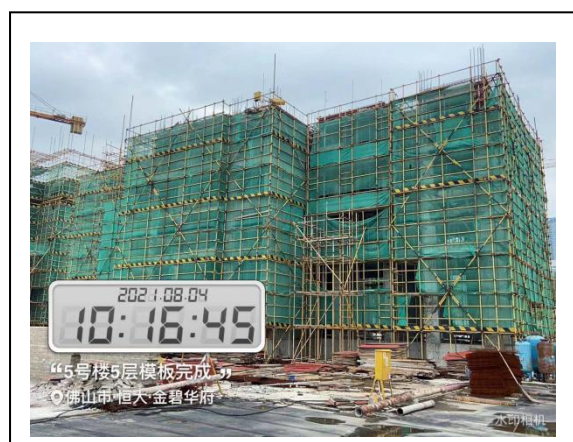
5#楼五层模板完成
