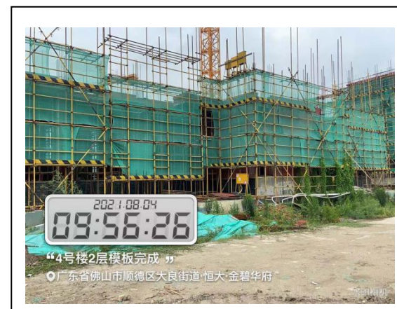
4#楼二层模板完成
