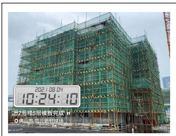
7#楼五层模板完成
