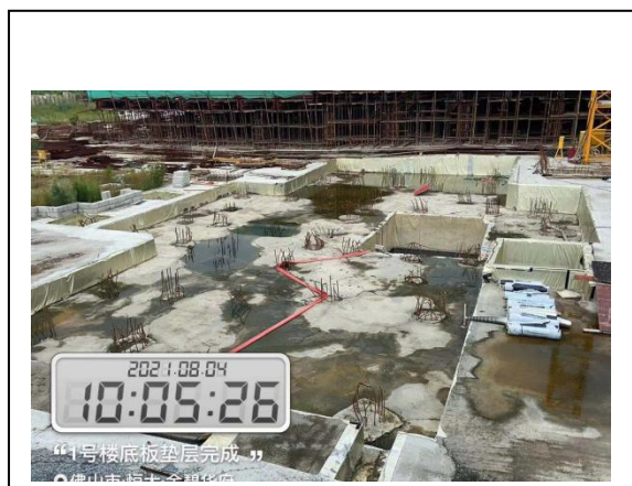
1#楼底板垫层完成
