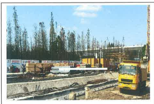
图 3.施工现场采购的材料
