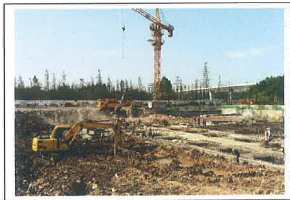
图 4.一期售楼部施工现场
