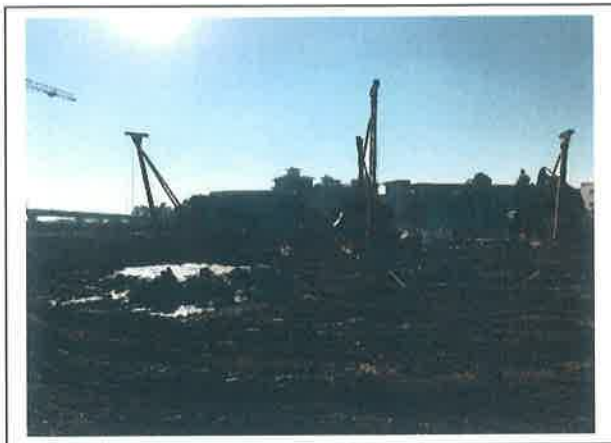
图 1.一期工程正在打桩
