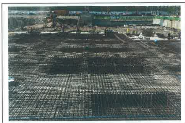
图 5.一期售楼部施工现场
