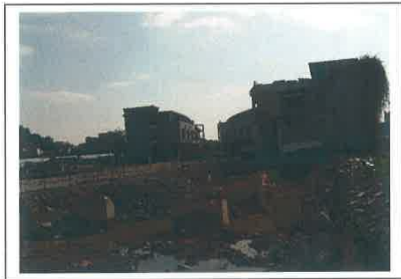
图 2.地块内未拆除建筑物
