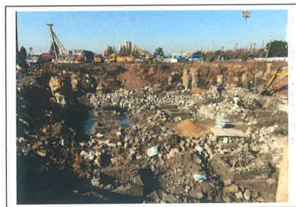
图 4. 一期售楼部施工现场
