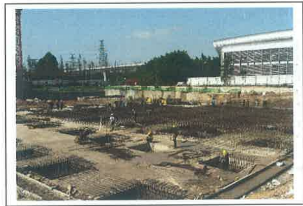
图 6. 一期售楼部施工现场
