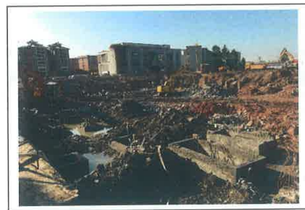
图 6.一期大面积钻孔打桩
