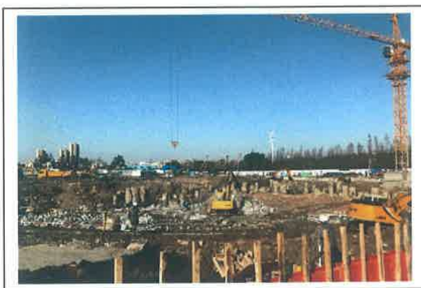
图 3. 一期售楼部施工现场
