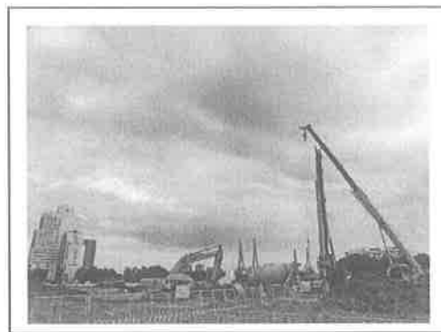
6.项目施工现场
