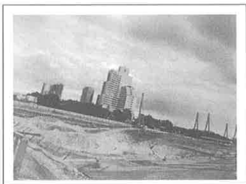
5. 项目施工现场
