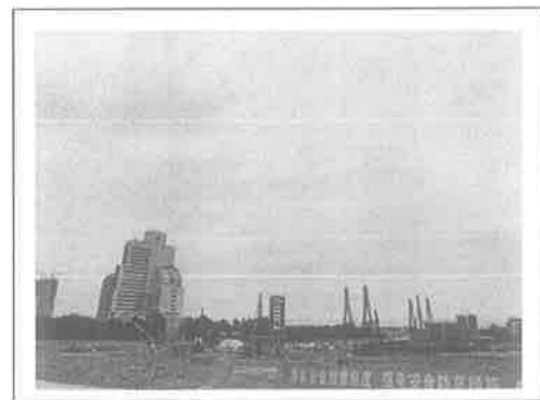
4.项目施工现场
