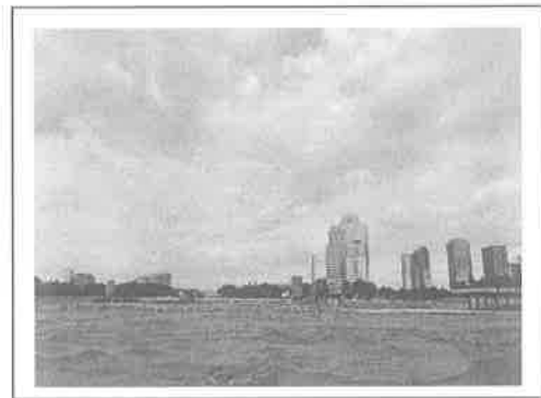
2.项目施工现场
