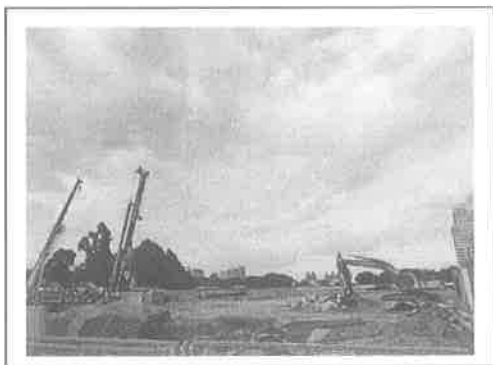
1.项目施工现场
