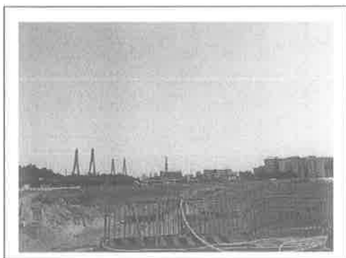
3.项目施工现场
