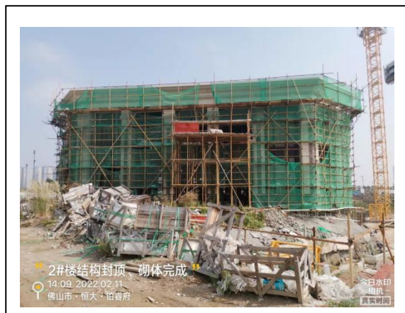
2#楼结构封顶、砌体完成
