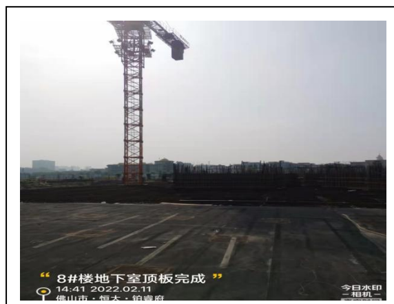
8#楼地下室顶板钢筋完成
