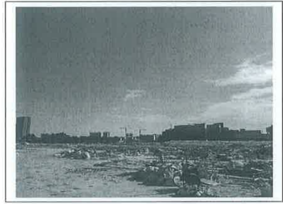
2、项目商铺拆除现场
