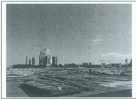
1、项目商铺拆除现场
