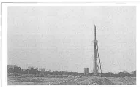
3.项目施工现场
