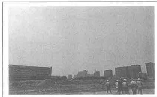
6.项目施工现场
