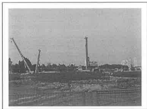
2.项目施工现场
