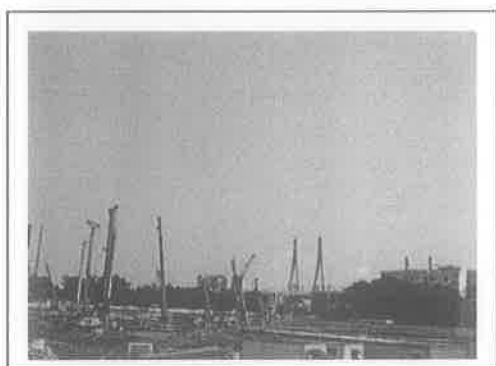
5. 项目施工现场
