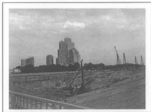
4.项目施工现场
