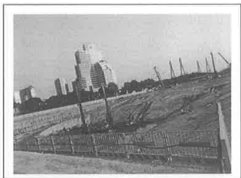
1.项目施工现场
