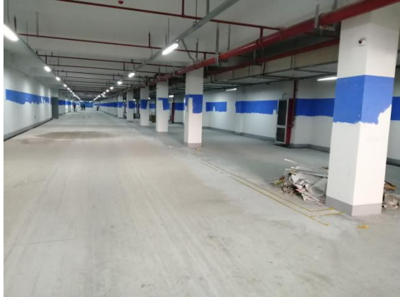
2、一期地下室现状
