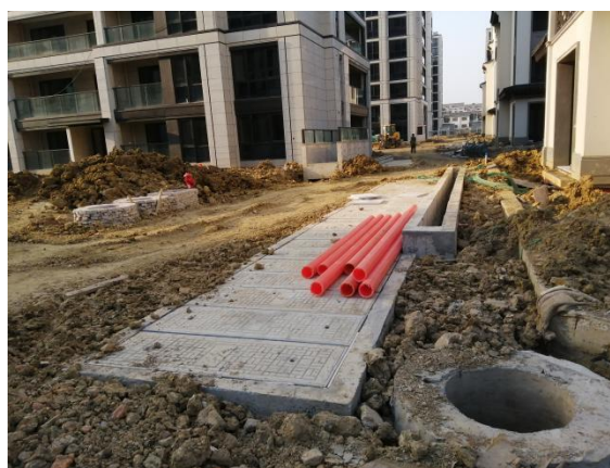
10、二三期室外施工现状
