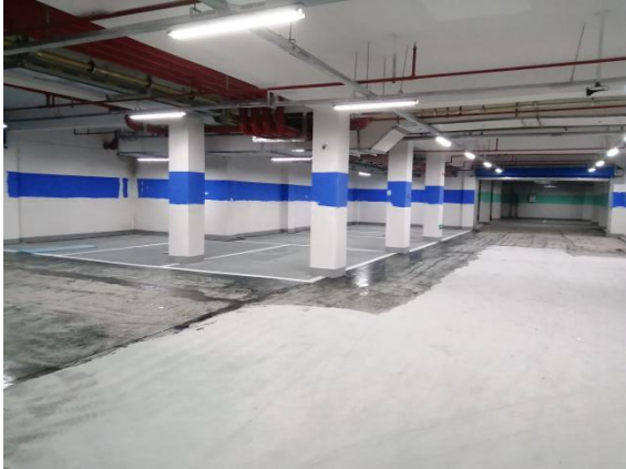
1、一期地下室现状
