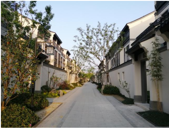
3、一期巷道现状
