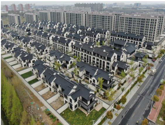
5、一二三期合院叠墅整体现状
