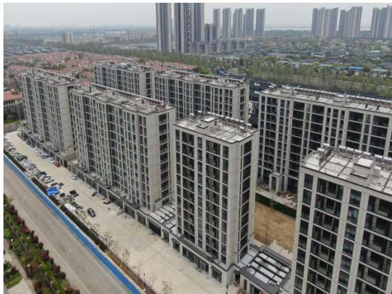
6、一期小高层整体现状
