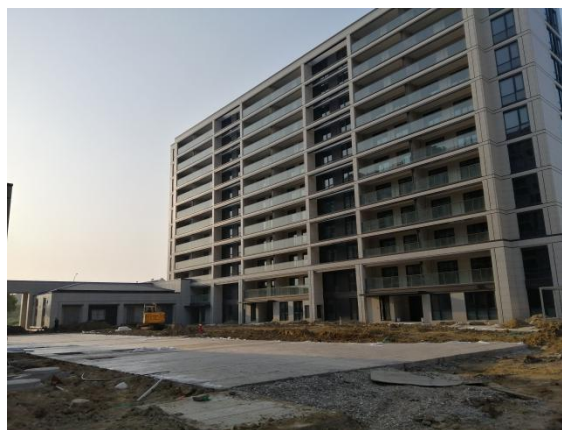
8、二三期室外施工现状
