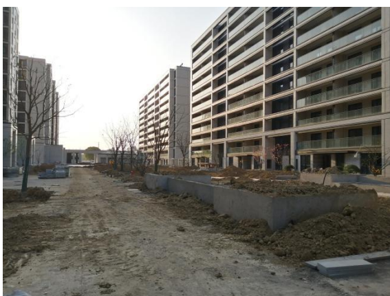
9、二三期室外施工现状
