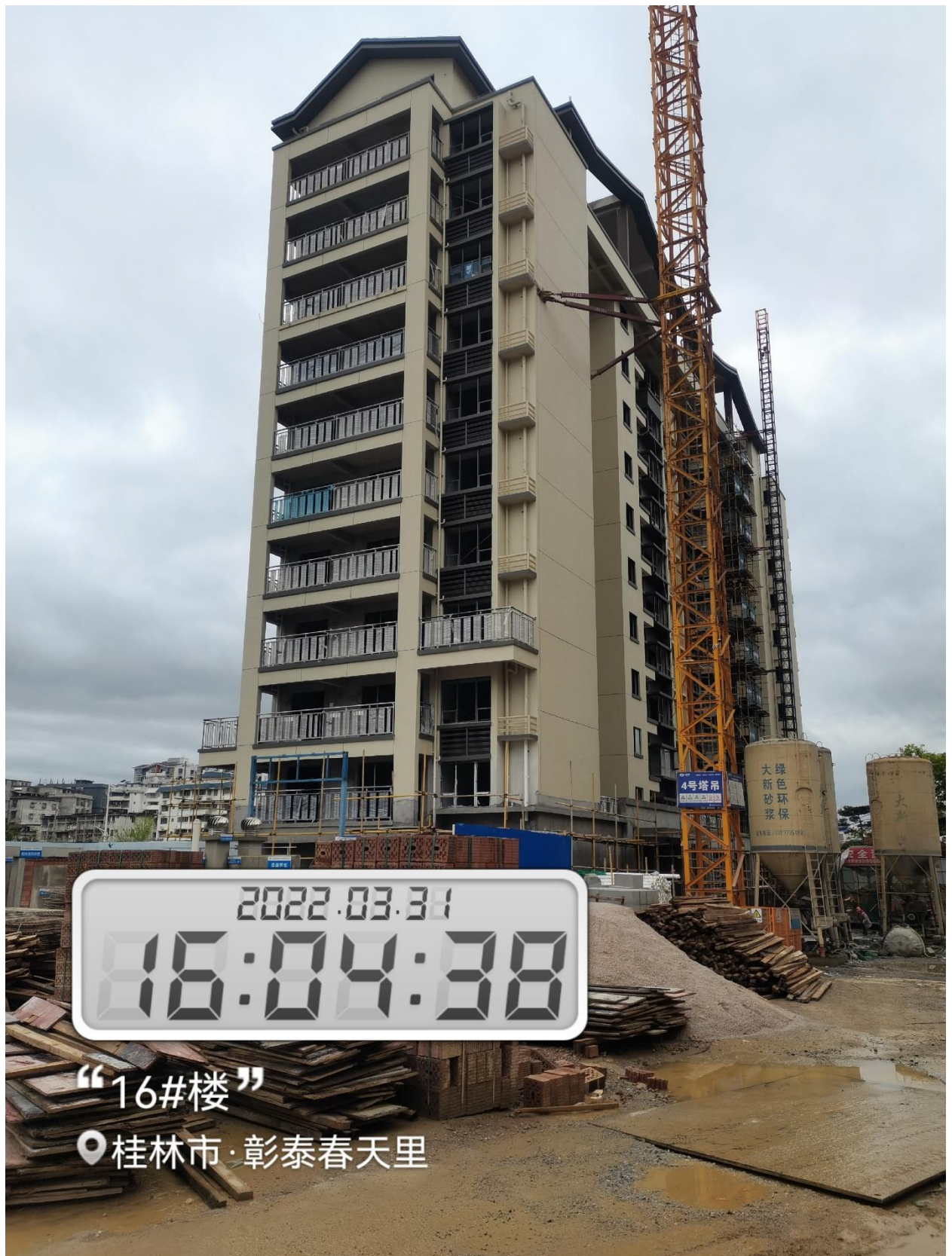
16#楼 2-12 层外墙涂料施工完成，1-12 层外架拆除完成，地面找平完成 2 层，屋面工程完成
