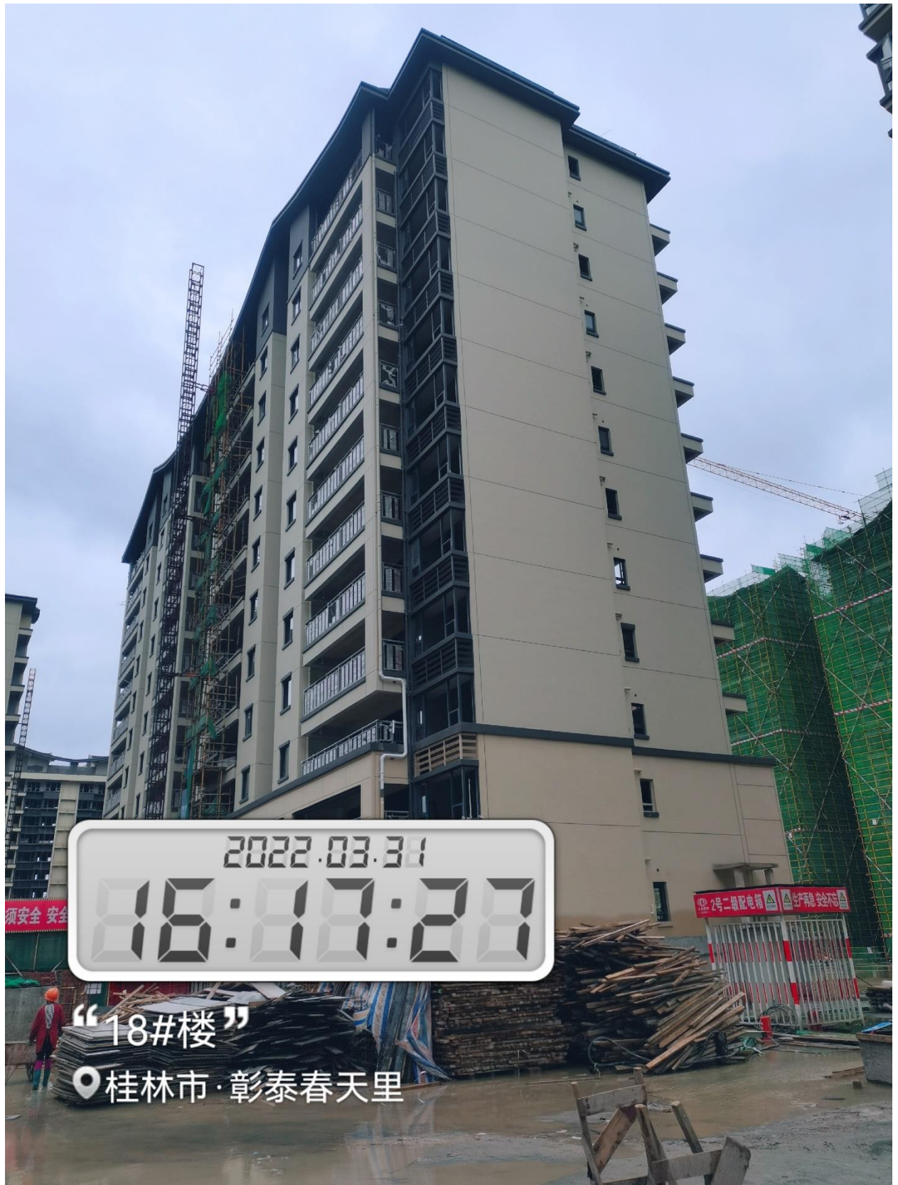
18#楼内外墙抹灰完成，外墙涂料施工完成，外架拆除完成，2-12层地面找平完成，窗扇安装完成
