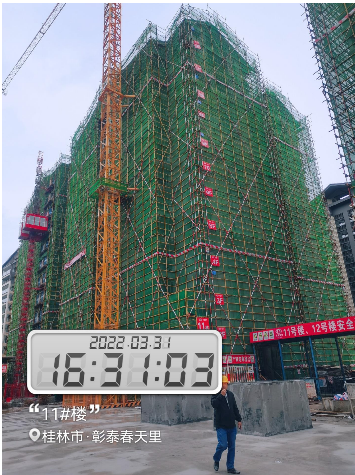
11#楼已主体结构封顶，2-7 层砌体完成，8-9 层砌筑完成 40%
