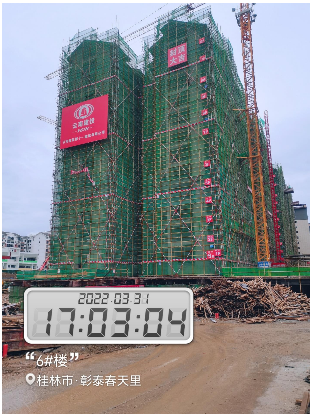
6#楼主体结构已封顶，12层及屋面模板拆除完成，11层垃圾清理完成
