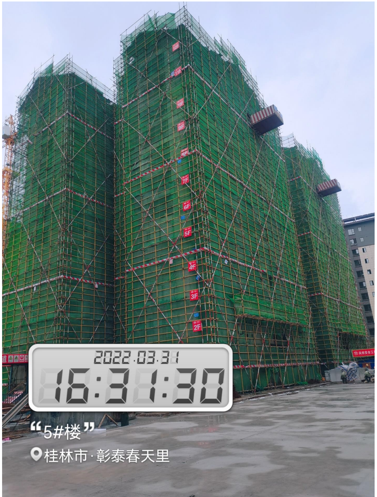
5#楼东单元斜屋面梁板钢筋完成，西单元斜屋面砼完成，2层砌体完成
