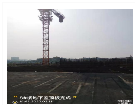
8#楼地下室顶板钢筋完成
