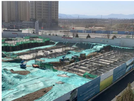
10. 1-7#、1-8#楼基础筏板浇筑完成
