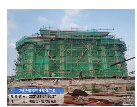
2#楼结构封顶、砌体完成
