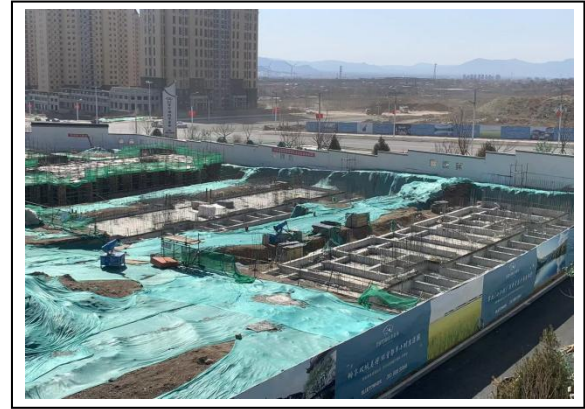
6.1-7#、1-8#楼基础筏板浇筑完成
