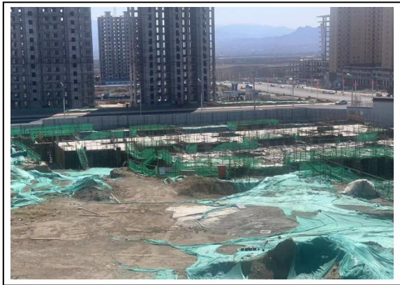
5.1-2#、1-3#地下室顶板浇筑完成
