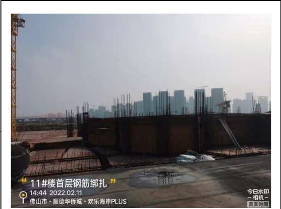
11#楼首层钢筋绑扎
