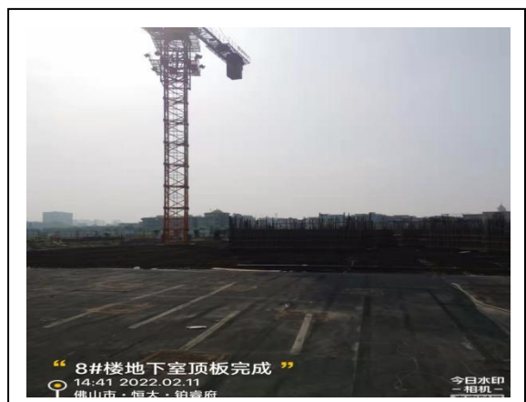
8#楼地下室顶板钢筋完成
