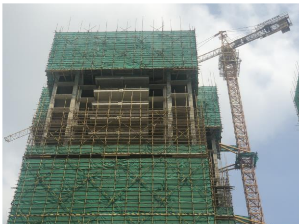
3.项目施工现场
