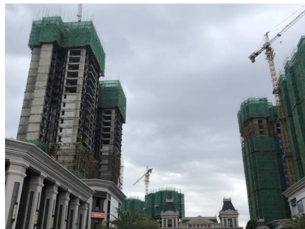
4.项目施工现场
