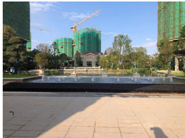
2.项目施工现场
