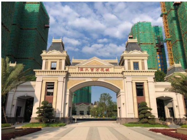
1.项目施工现场
