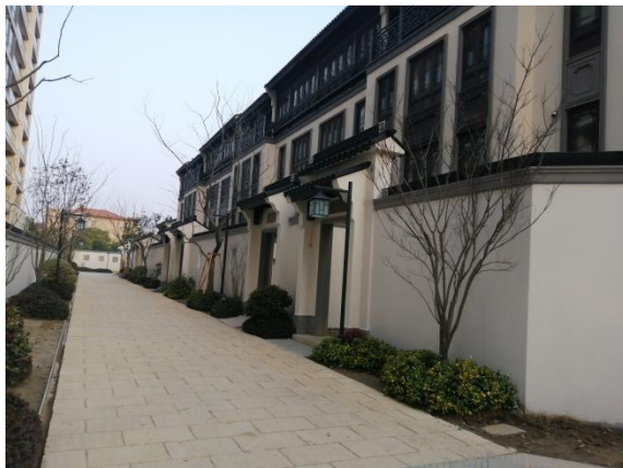
4、一期巷道现状
