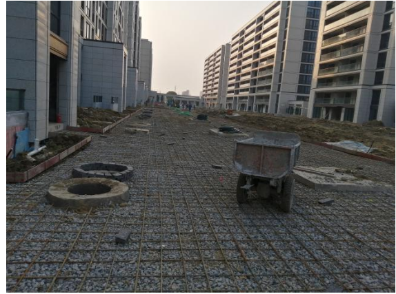
8、二三期室外施工现状
