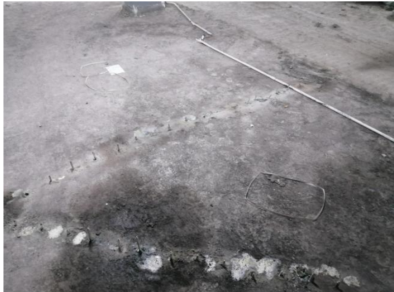
2、一期地下室注浆
