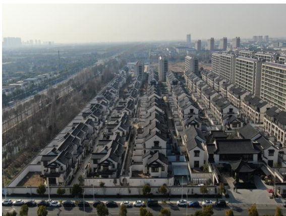
5、一二三期合院叠墅整体现状
