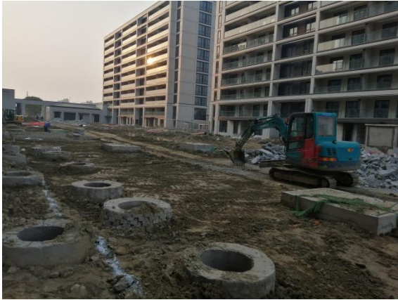
7、二三期室外施工现状
