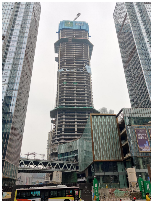
T1 塔楼东立面 53 层
