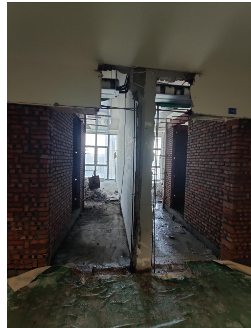
T2 塔楼酒店装修 03
