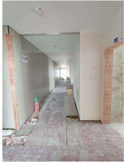
T2 塔楼酒店装修 01
