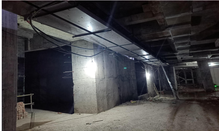
地下车库施工 01
