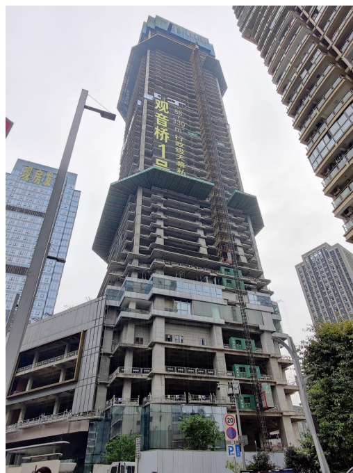
T1 塔楼西立面 53 层
