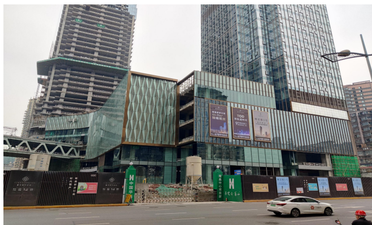
北裙房东南立面
