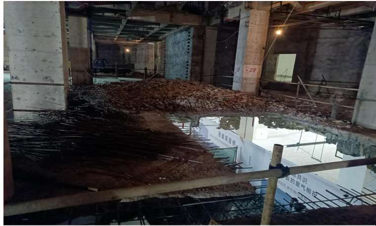
裙房改造施工
