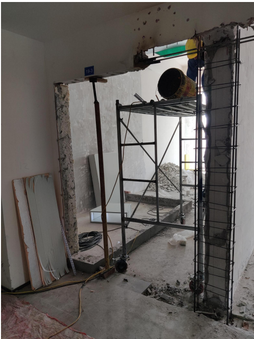
T2 塔楼酒店装修 02
