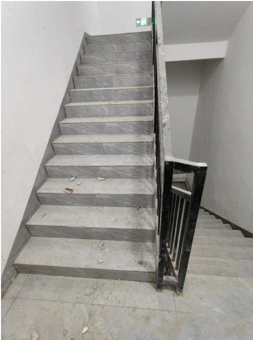
T2 塔楼楼梯间贴砖
