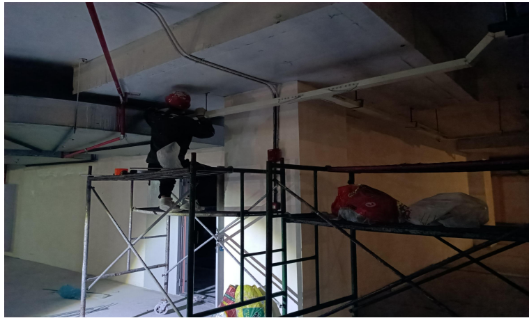
地下车库施工 02
