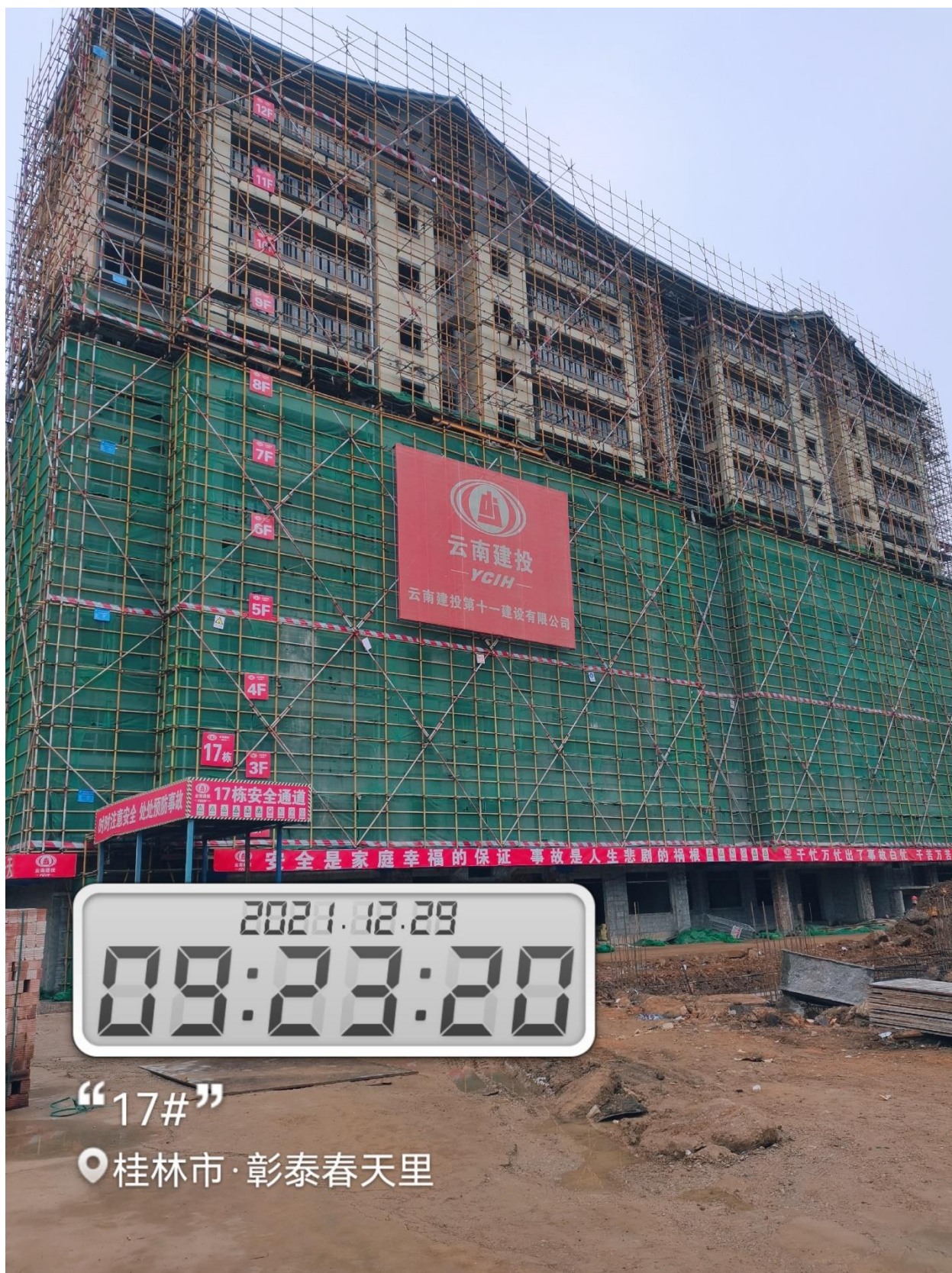
17#楼 1-12 层内墙抹灰完成，8-12 层外墙涂料施工
