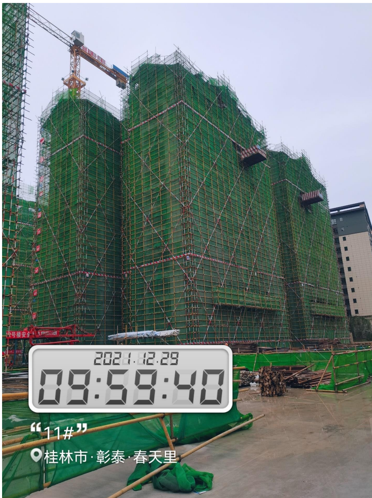
11#楼斜屋面混凝土浇筑完成
