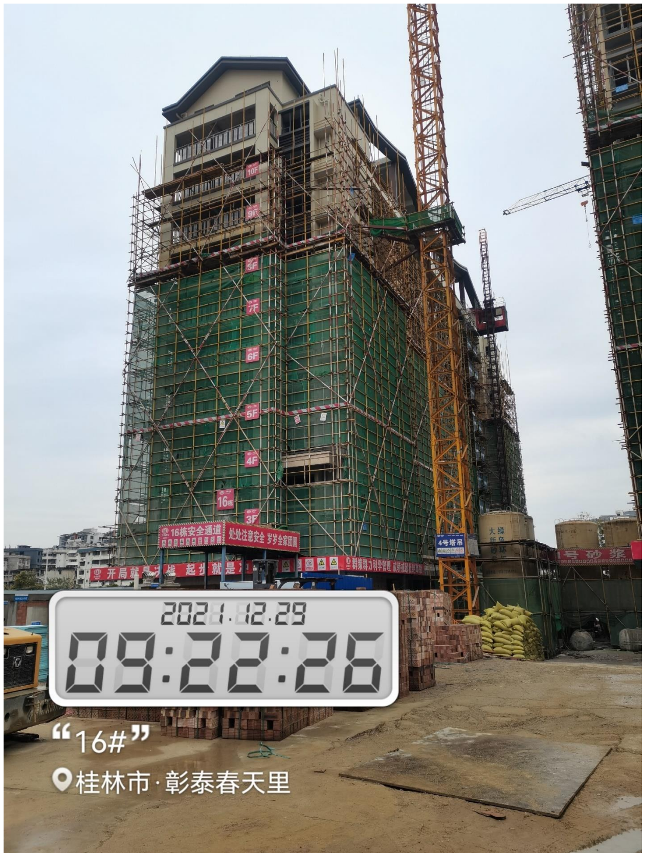
16#楼 8-12 层外架拆除基本完成，1-8 层外墙涂料施工
