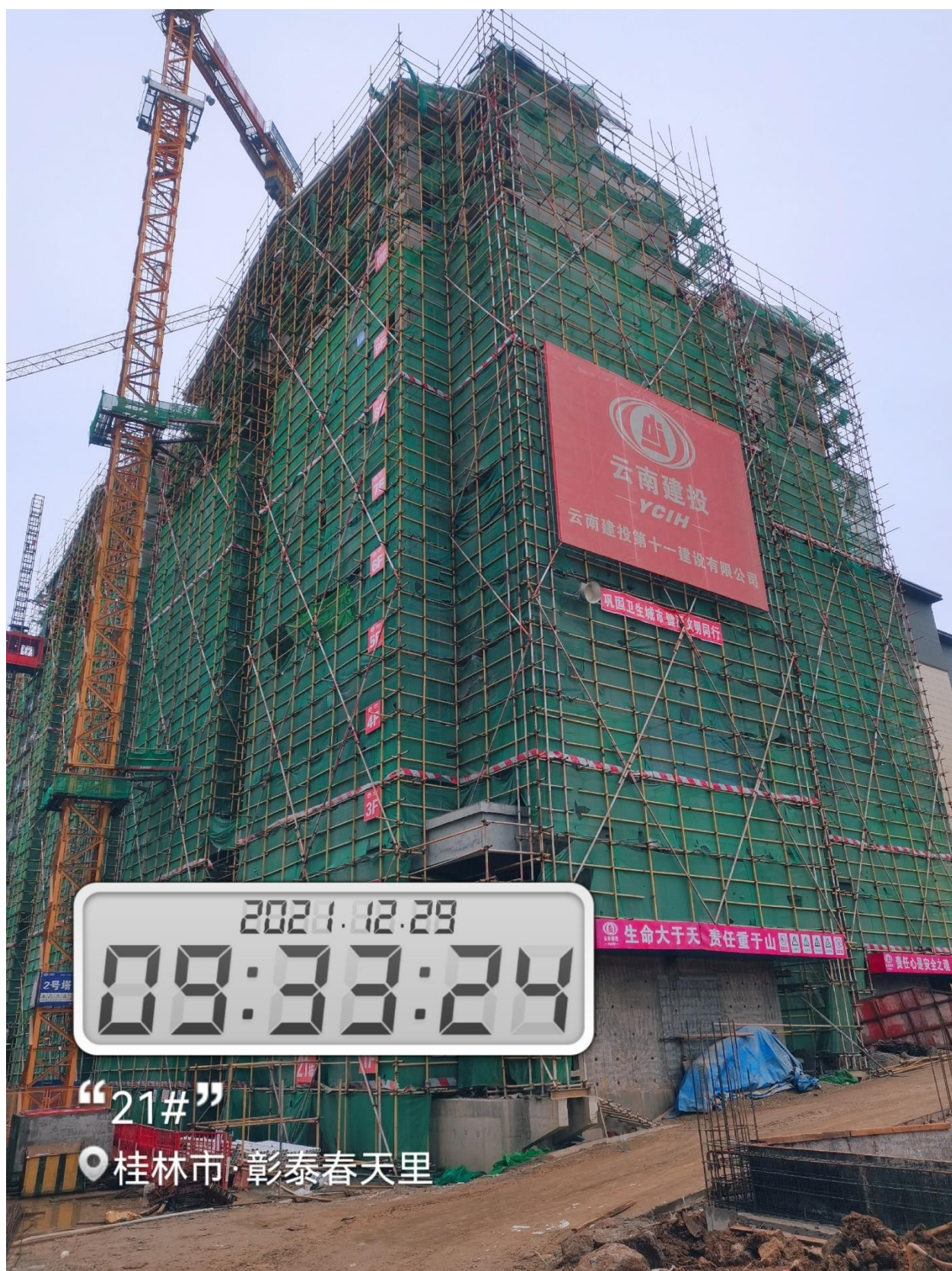
21#楼 8-12 层外墙涂料施工，内墙抹灰 1-11 层完成
