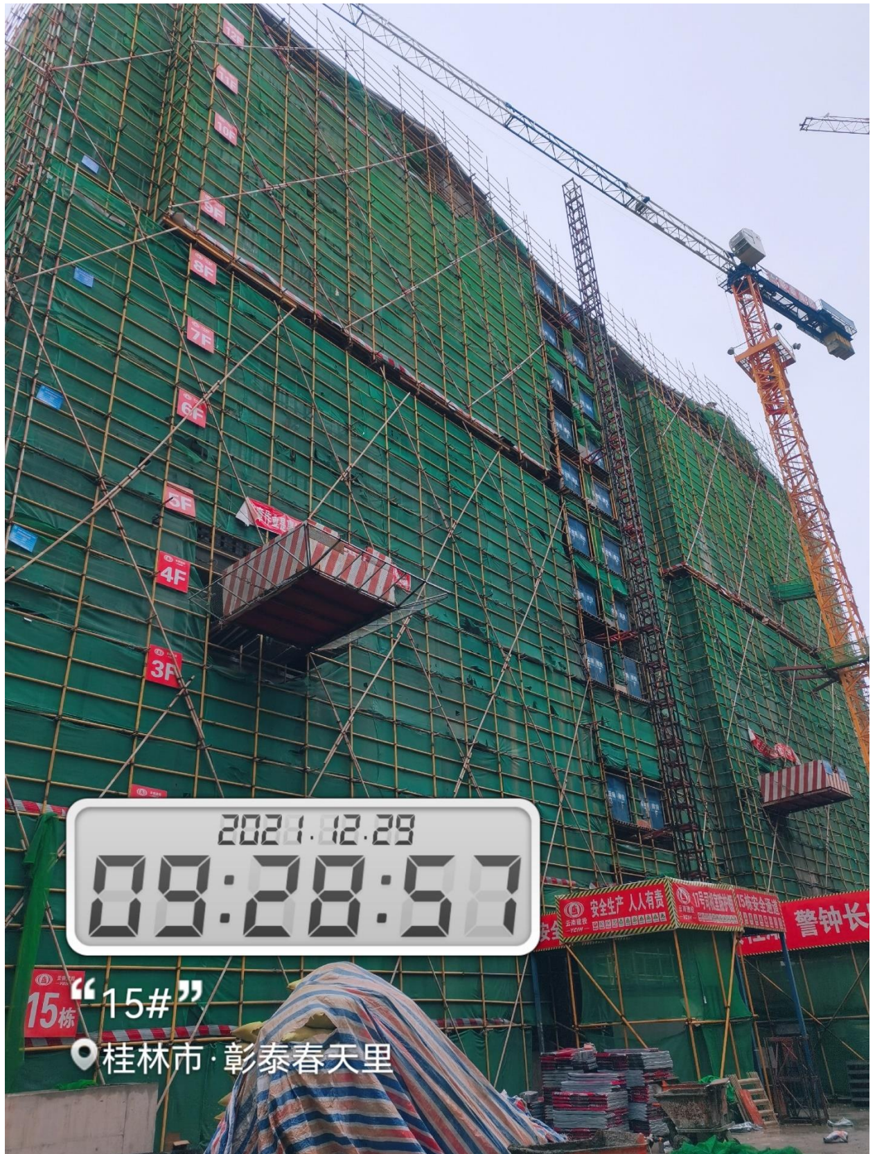
15#楼内墙抹灰 1-11 层完成，外墙抹灰 2-12 层完成，开始外墙腻子施工
