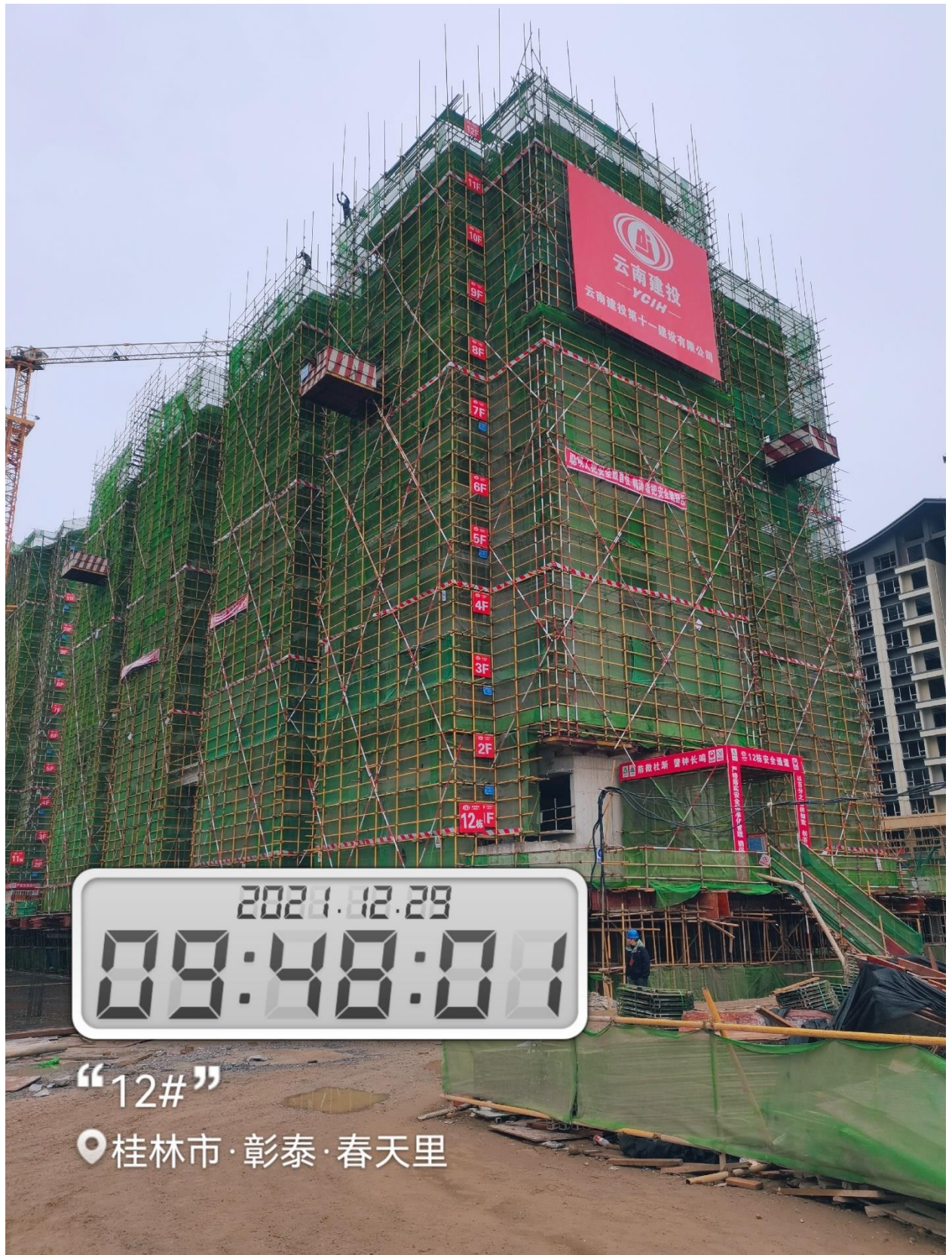
12#楼一单元 12 层混凝土完成平屋面支模，二单元 11 层混凝土完成 12 层梁板支模
