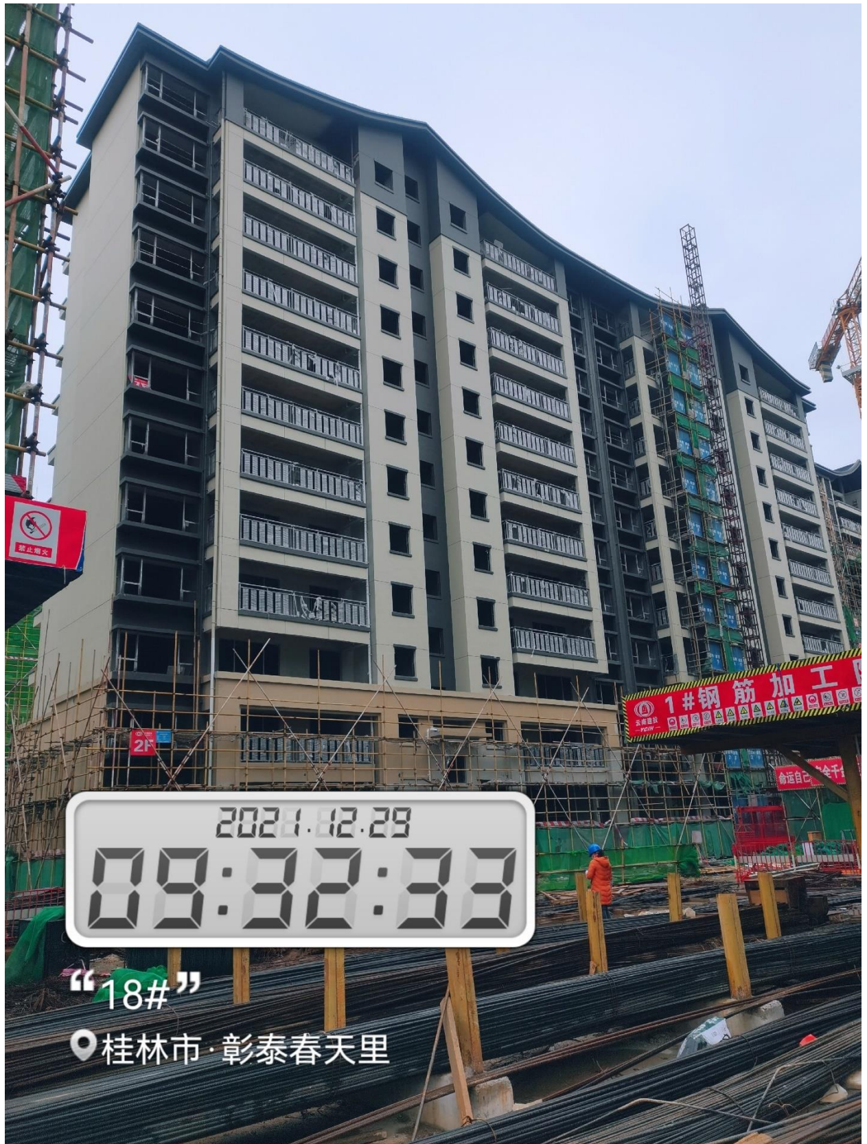
18#楼内墙抹灰完成，外墙涂料 12-3 层完成，外架拆除 12-3 层
