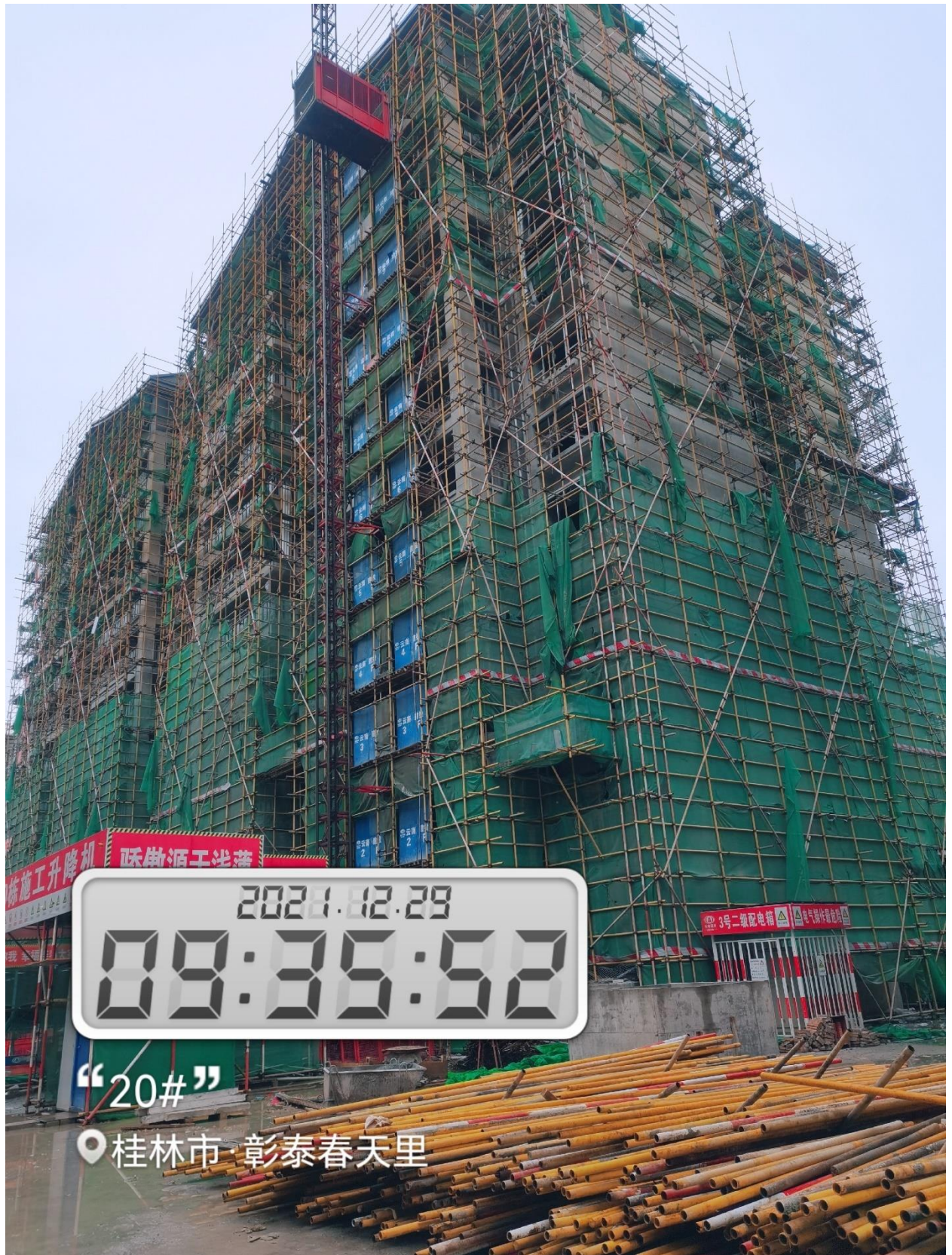
20#楼 7-3 层地面完成，外墙抹灰 1-12 层完成，外墙涂料 12-8 层完成
