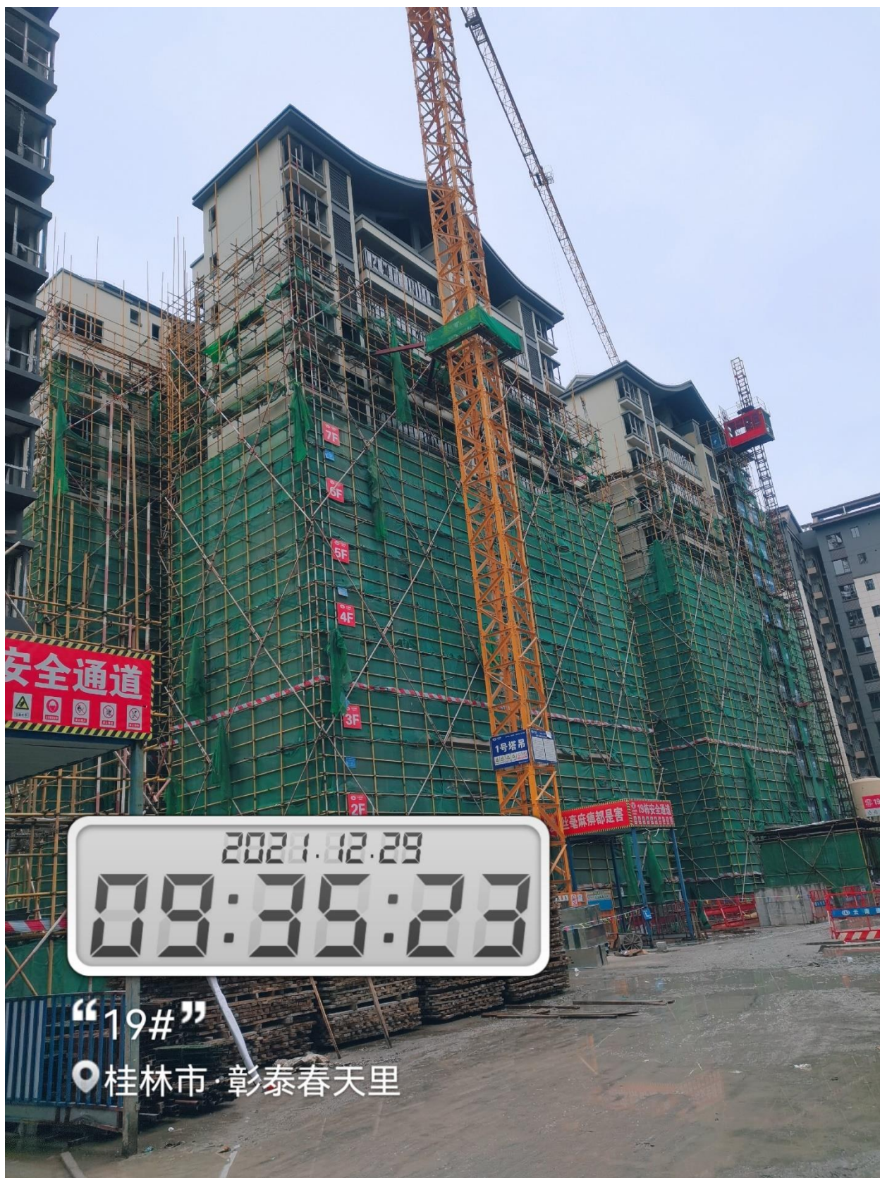
19#楼内墙抹灰 1-12 层完成，外墙涂料 12-8 层完成，12-8 层外架拆除
