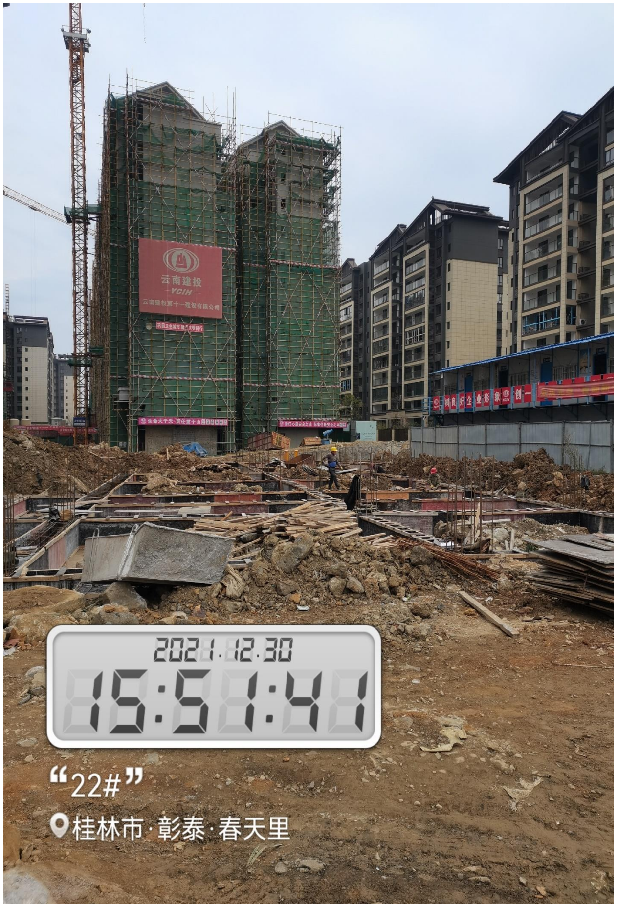
22#楼基础地梁支模基本完成
