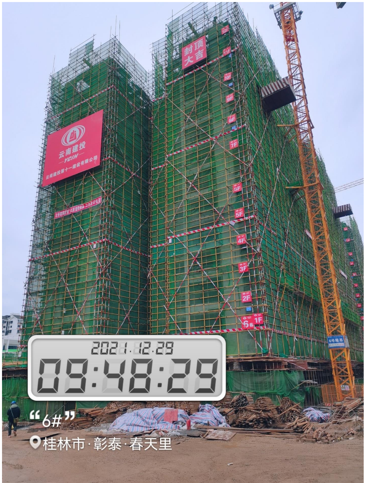
6#平屋面混凝土浇筑完成，一单元斜屋面梁板安装基本完成，二单元斜屋面梁板安装 30%
