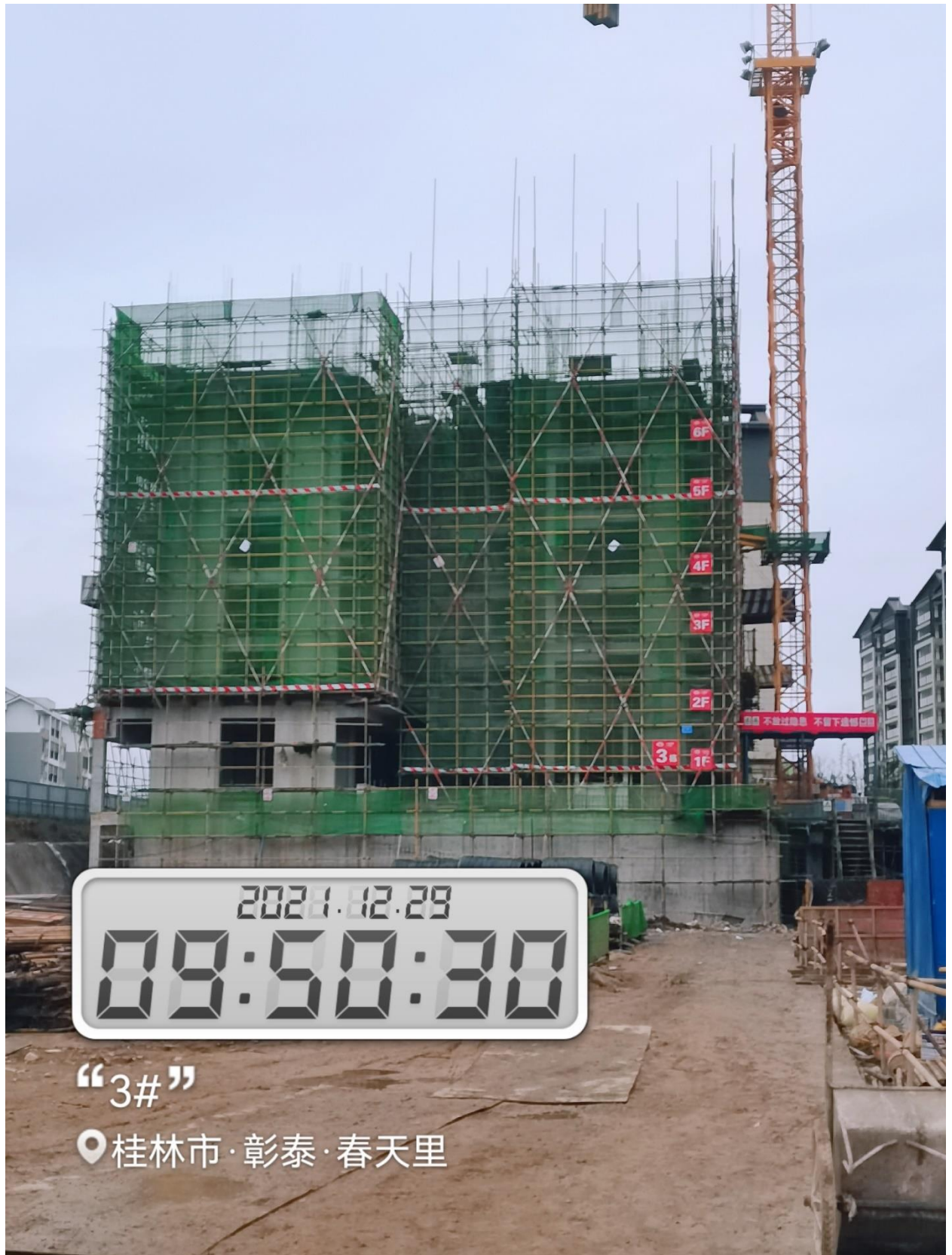
3#楼一单元 7 层钢筋绑扎完成，二单元 8 层梁板支模
