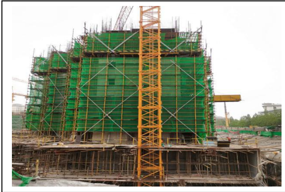
1、1#楼八层梁板柱钢筋绑扎、模板安装
