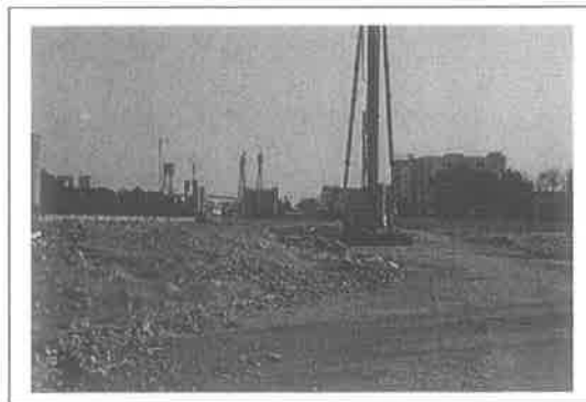
5. 项目现场情况
