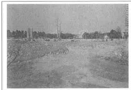
4. 项目现场情况
