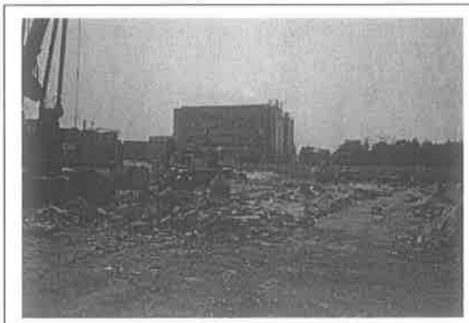
6. 项目现场情况
