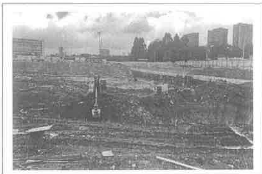
1. 项目施工现场一览
