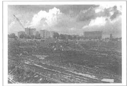
2. 项目施工现场一览
