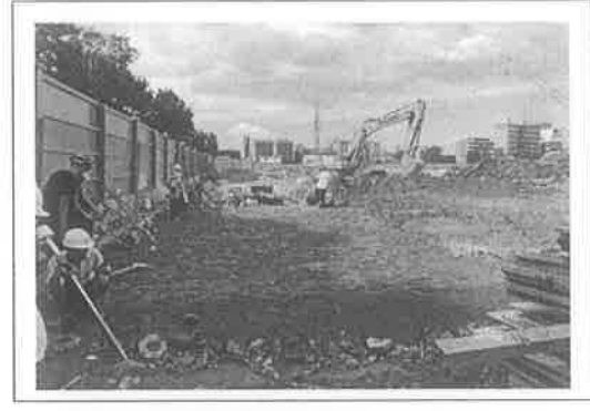
4. 项目一期施工现场
