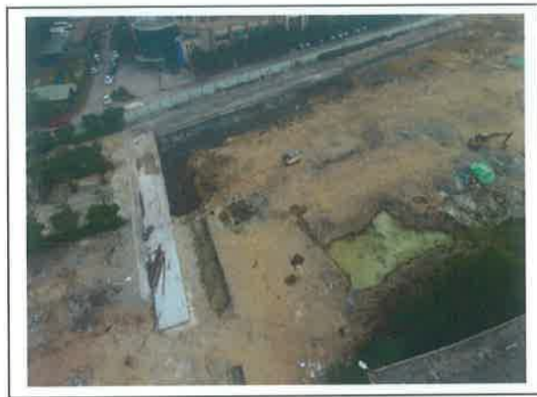
图 2. 施工现场部分基坑已灌注水泥
