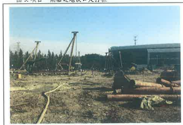
图 5. 项目一期钻孔打桩
