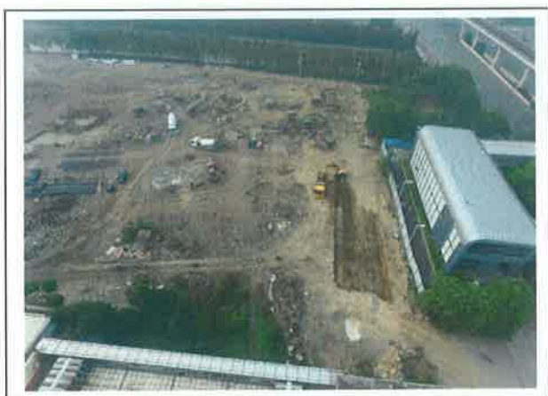
图 1. 邻近地铁处施工状况
