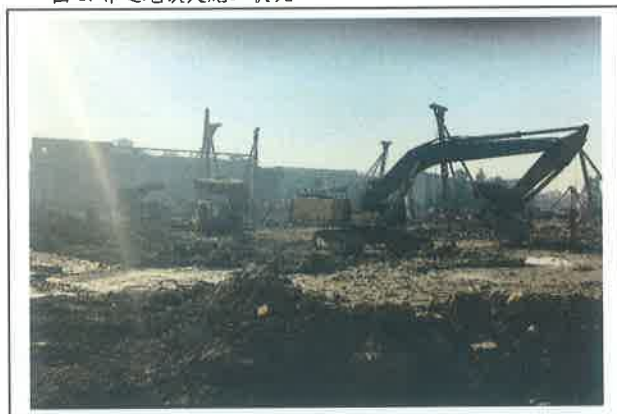
图 3. 项目一期临近地铁口处打桩
