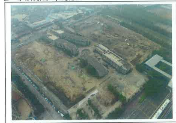
图 6. 整个地块施工情况鸟瞰图
