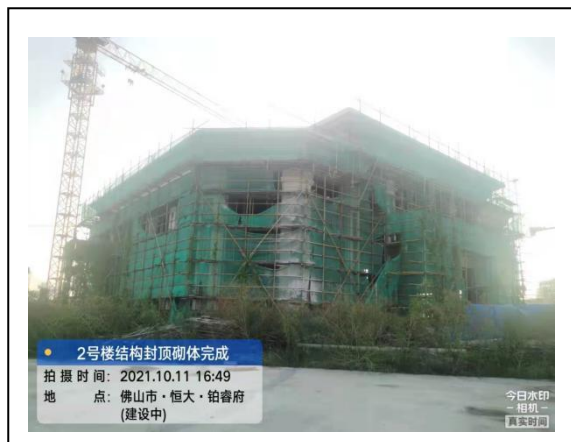
2#楼结构封顶、砌体完成
