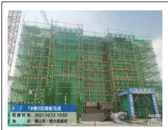
7#楼五层模板完成
