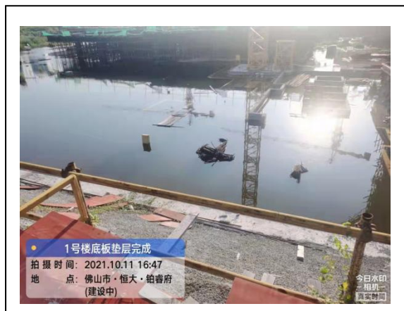
1#楼底板垫层完成
