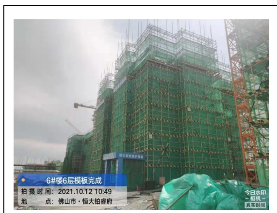
6#楼 6 层模板完成
