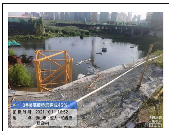
3#楼地板垫层完成 45%
