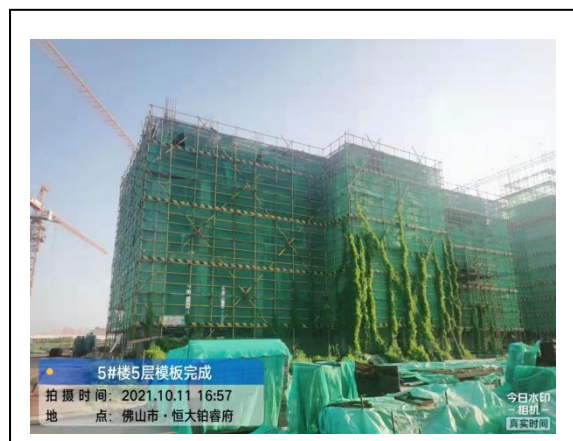
5#楼五层模板完成
