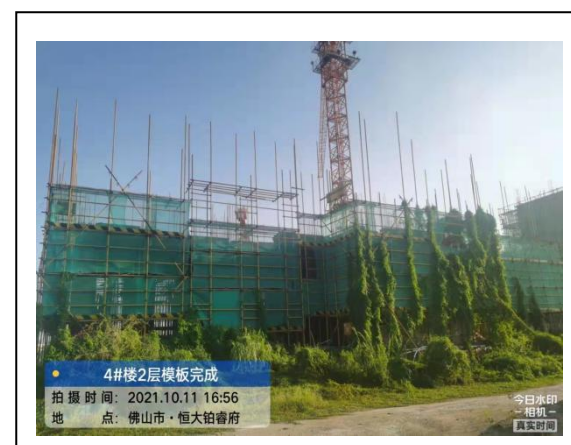
4#楼二层模板完成
