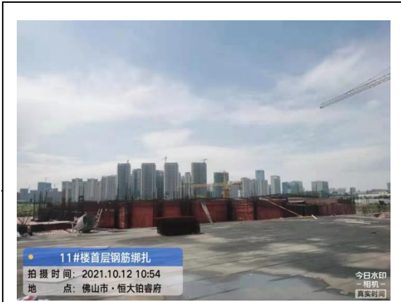
11#楼首层钢筋绑扎
