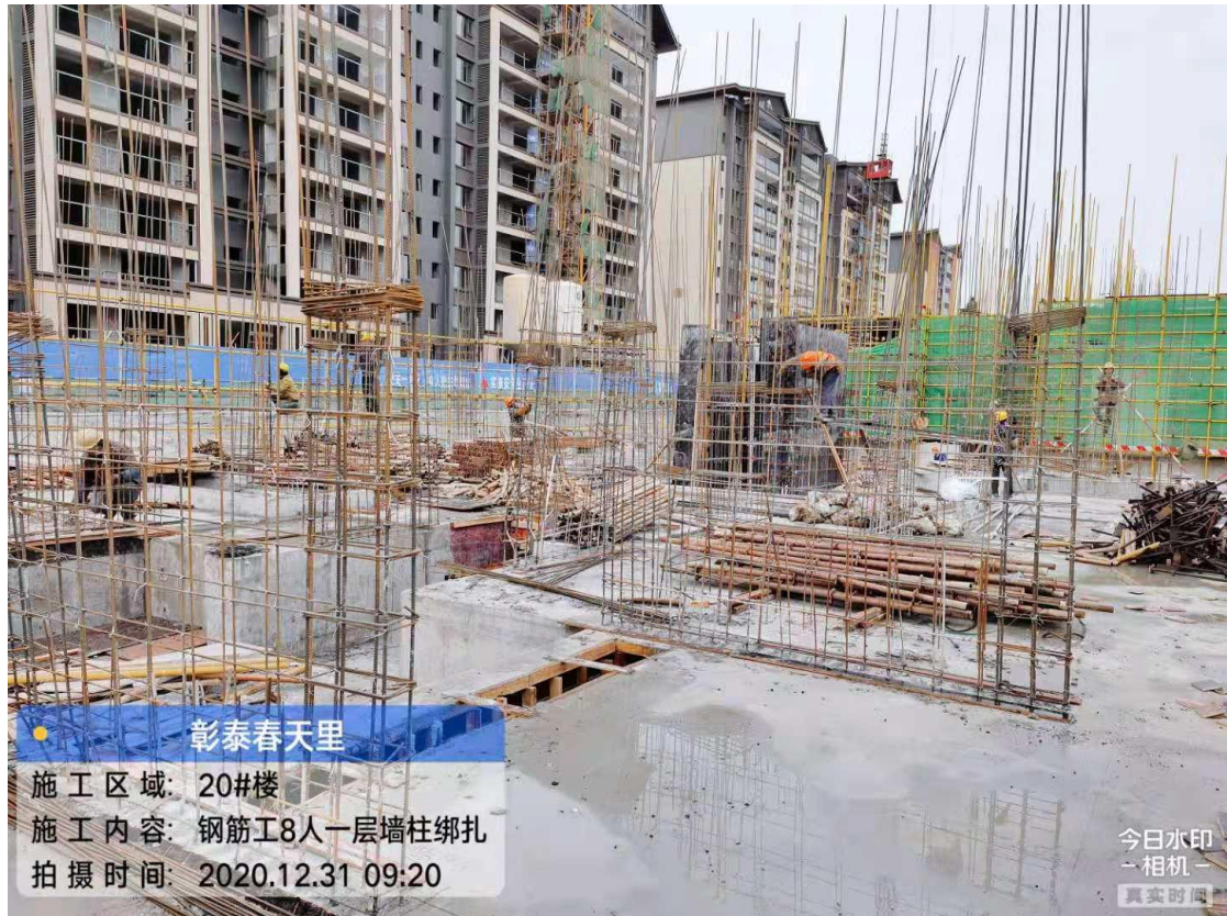
20#楼一层墙柱钢筋绑扎约 30%
