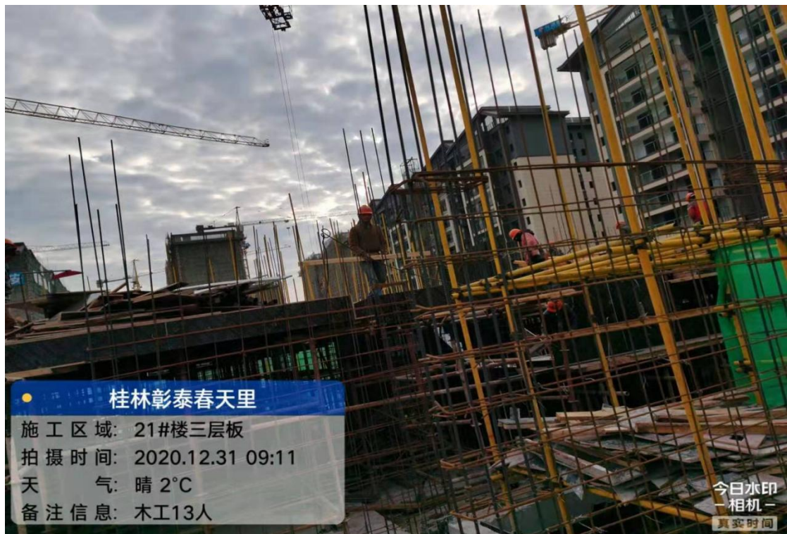
21#楼三层梁板模板安装完成 30%
