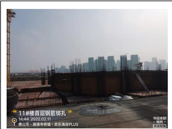
11#楼首层钢筋绑扎
