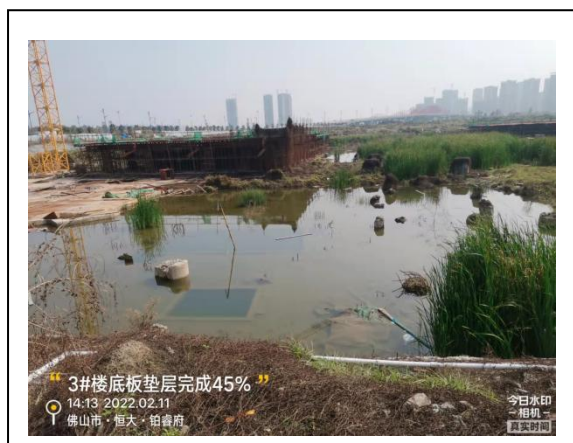
3#楼地板垫层完成 45%
