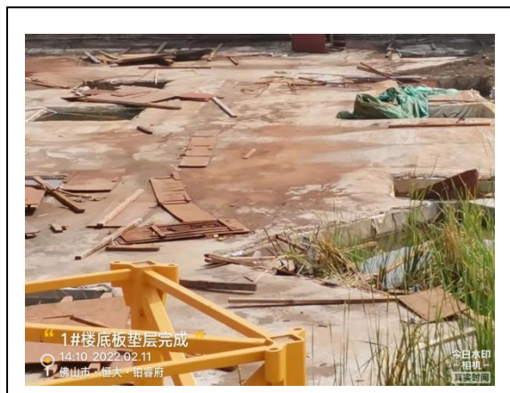
1#楼底板垫层完成
